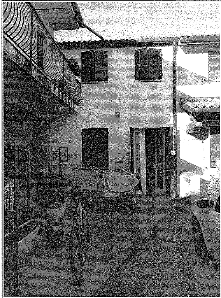
Foto n. 1 – esterno – sud (Ingresso)
