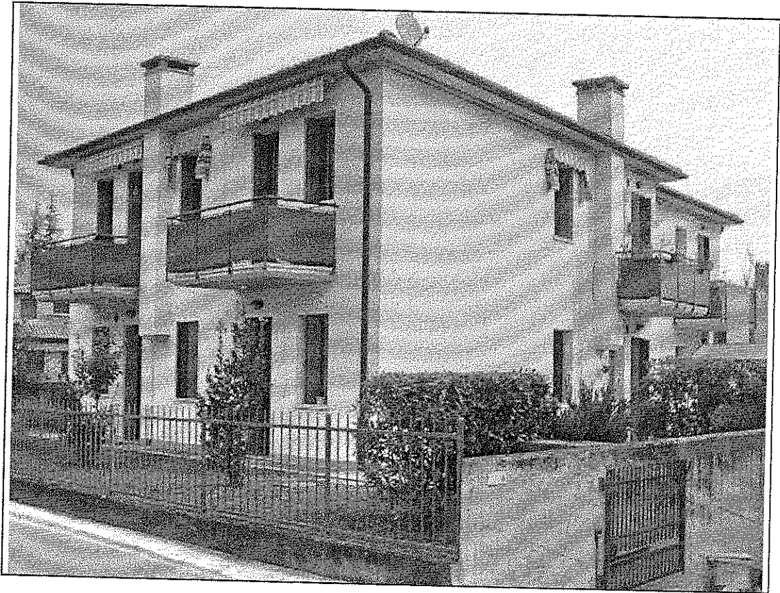
Foto 01 – Fronte sud-ovest, da via Caldemessa
