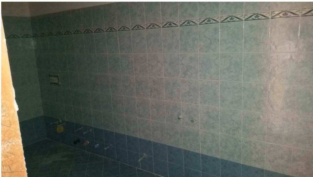
Foto n.12: Bagno al Piano Primo (Mapp.1132)
