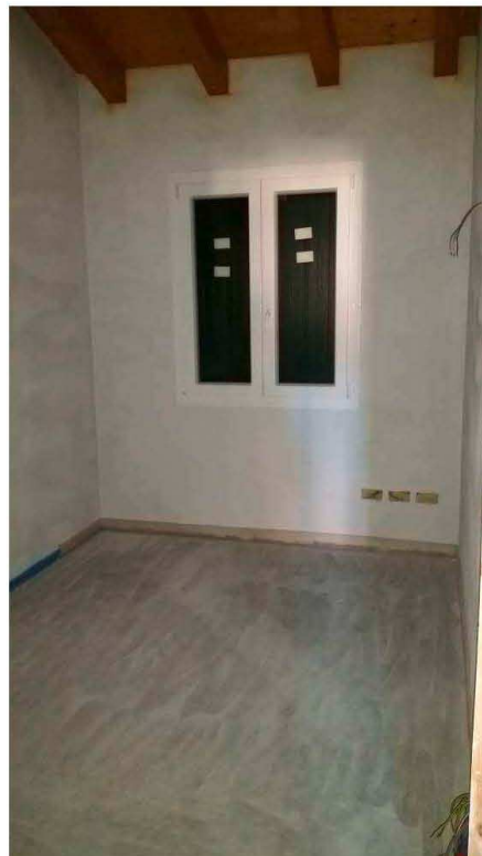
Foto n.28: Camera al Piano Primo (Mapp.1127)
