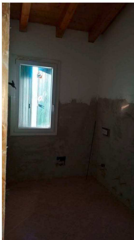
Foto n.21: Camera al Piano primo (Mapp.1131)
