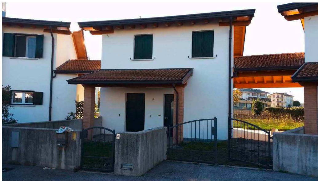
Foto n.5: Prospetto Sud-Est della villetta a schiera ( Mapp.1132 ) oggetto di E.I.
