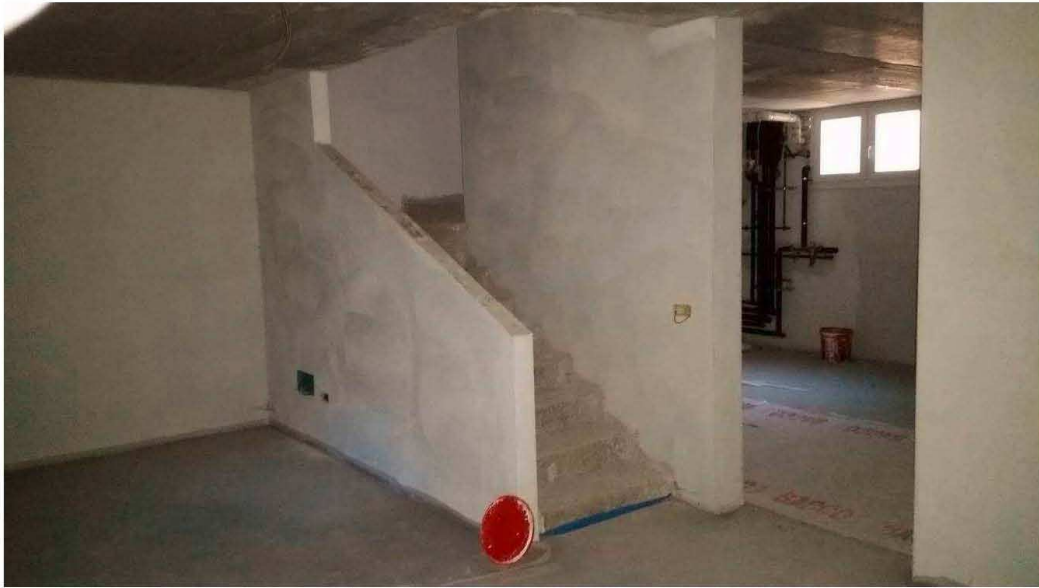
Foto n.19: Cantina al Piano Interrato ( Mapp.1131 )
