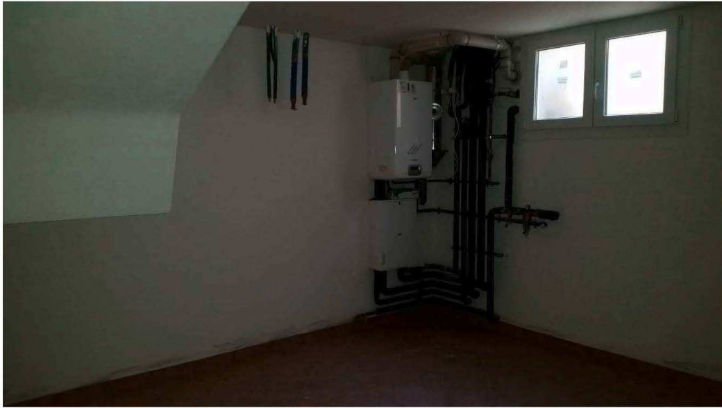
Foto n.11: Cantina al Piano Interrato (Mapp.1132)
