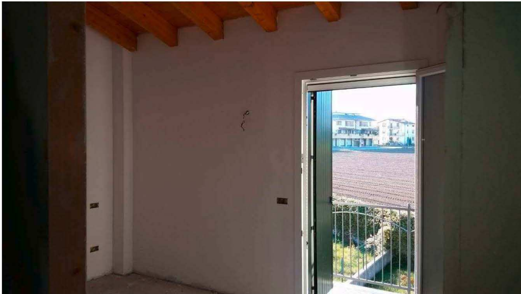
Foto n.20: Camera al Piano primo ( Mapp.1131 )
