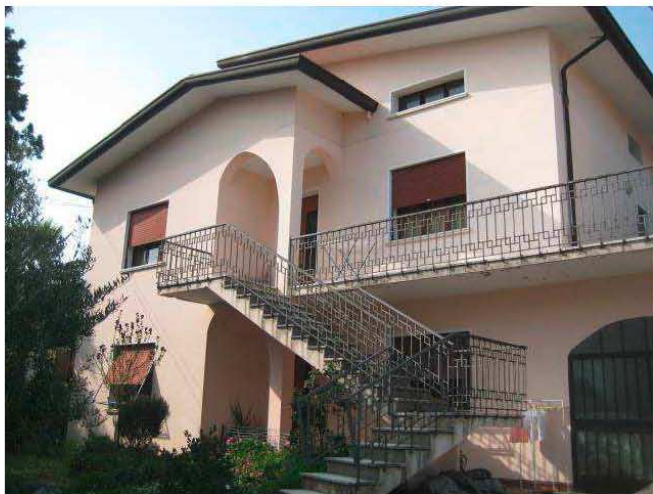
Veduta scala esterna d'accesso all'immobile
