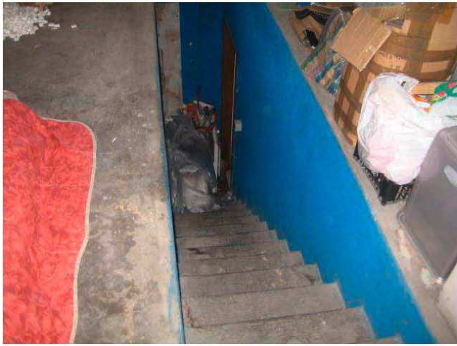
Veduta scala accesso p. 2
