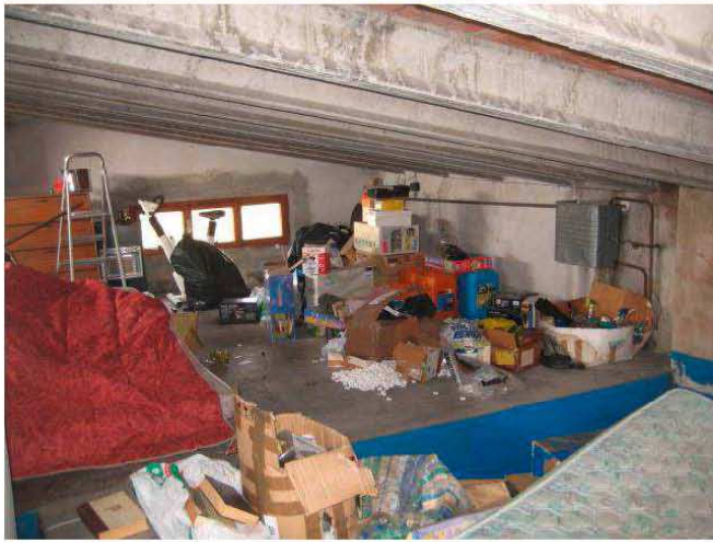
Veduta soffitta p. 2
