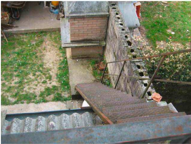
Veduta scala metallica per accesso zona retrostante
