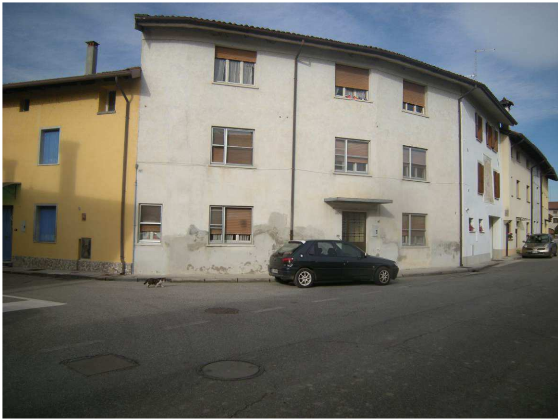
Spilimbergo, Via S. Stefano 16 - Il prospetto a sud-est dell'edificio.
