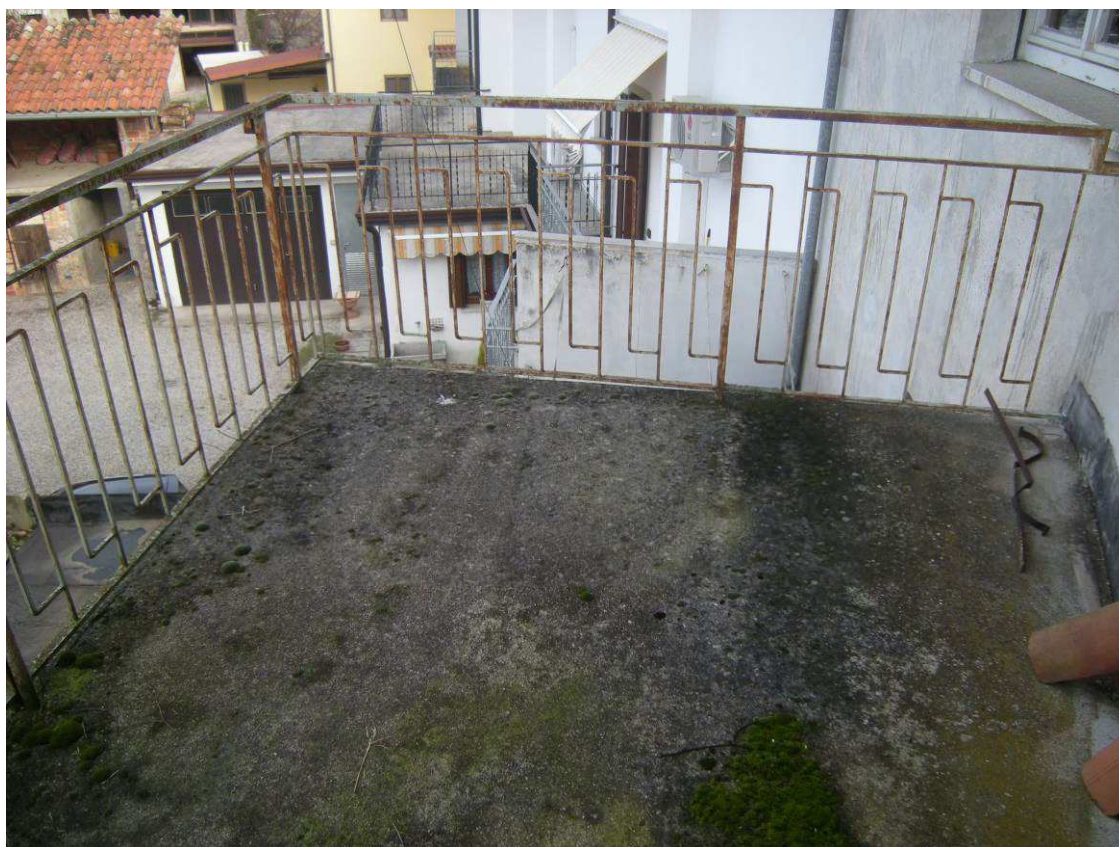
Spilimbergo, Via S. Stefano 16 –Piano Secondo - Il terrazzo a livello sul prospetto a nord – ovest.
