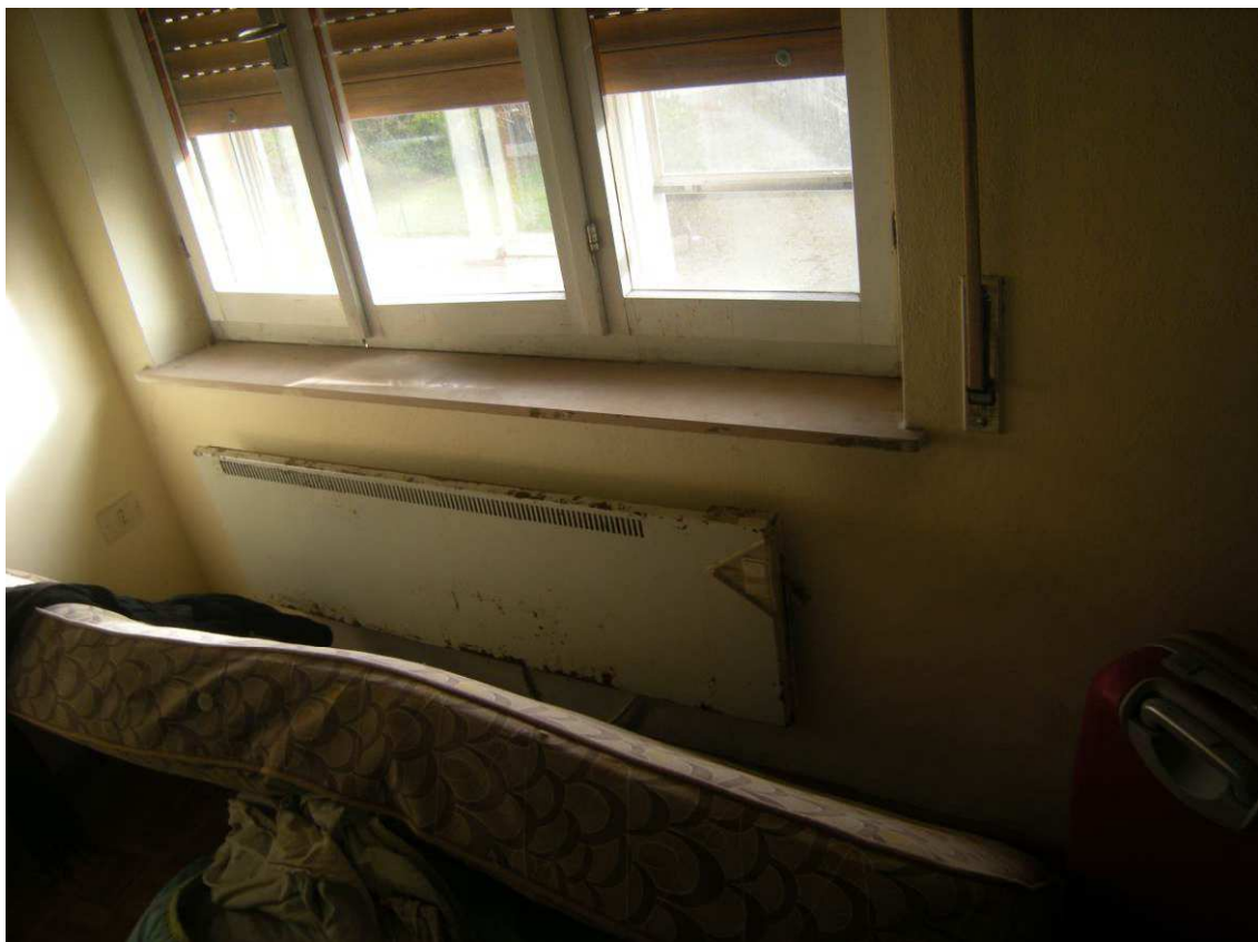
Spilimbergo, Via S. Stefano 16 –Piano Primo - La camera 3.
