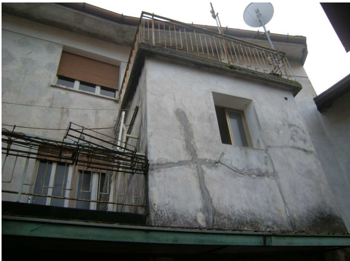
Spilimbergo, Via S. Stefano 16 - Il prospetto a nord - ovest dell'edificio.
