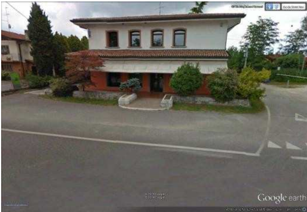
Foto 2 Vista frontale del fabbricato
