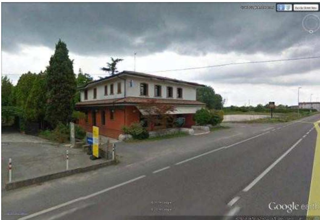
Foto 1 Vista del fabbricato da Via Marconi
