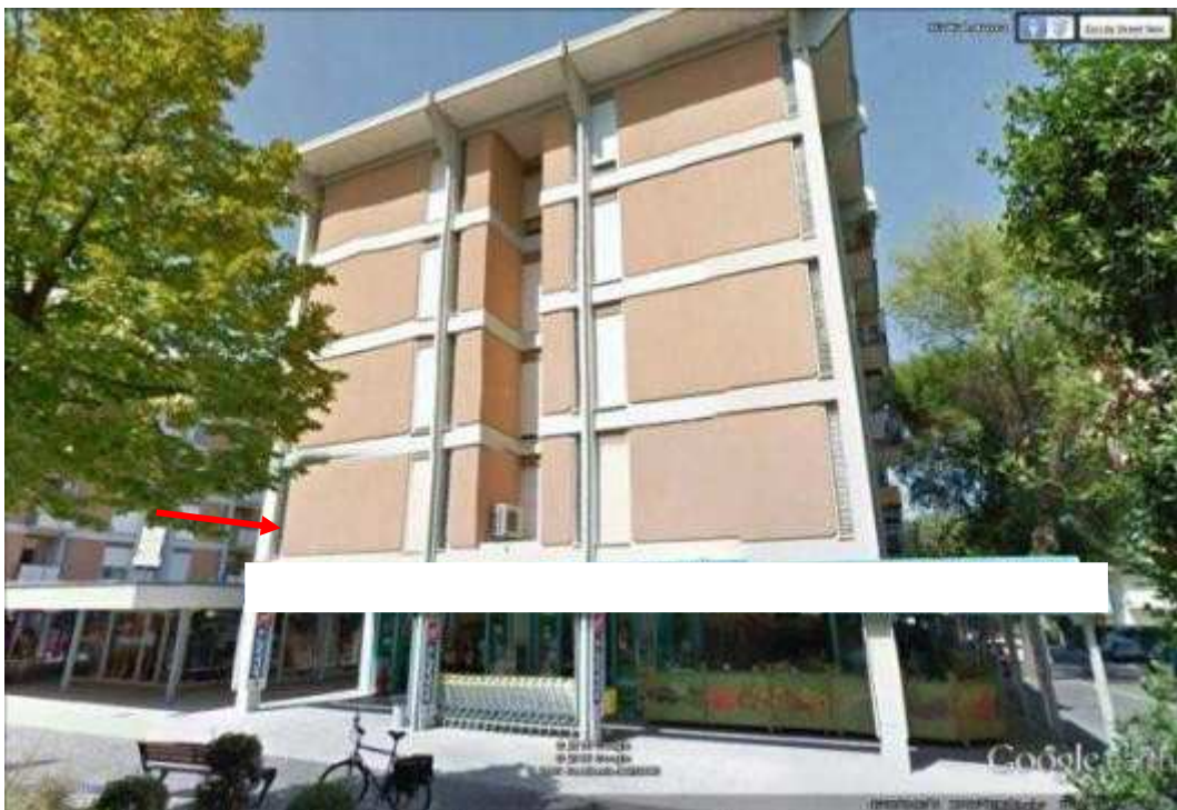
Foto 1 Vista del fabbricato da Viale Aurora
