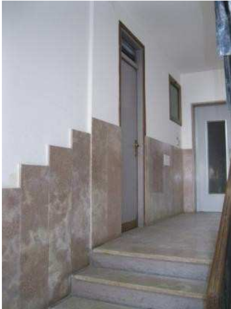
Foto 8 Scala condominiale ed ascensore
