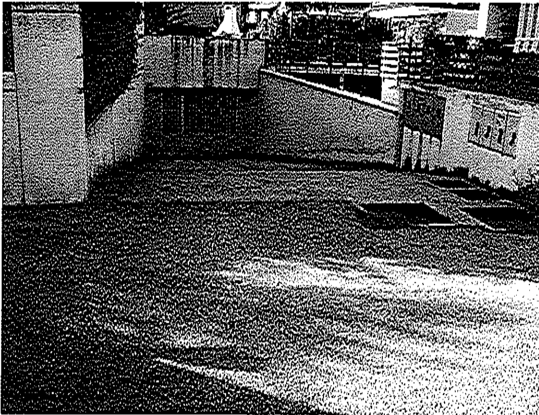
Foto 1: Vista da Est
