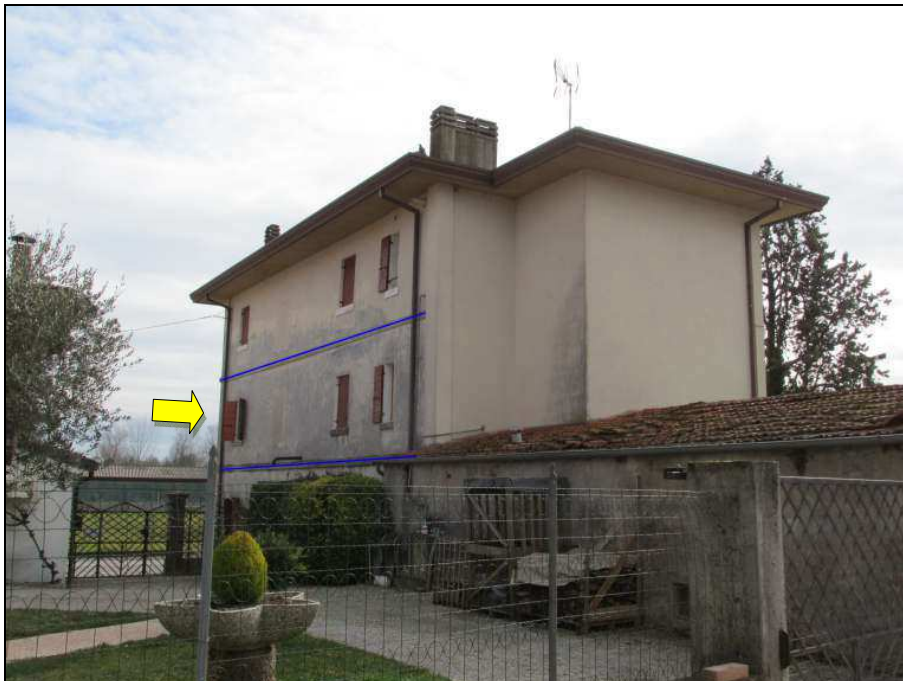
Fig.4: vista lati nord ed ovest della palazzina
