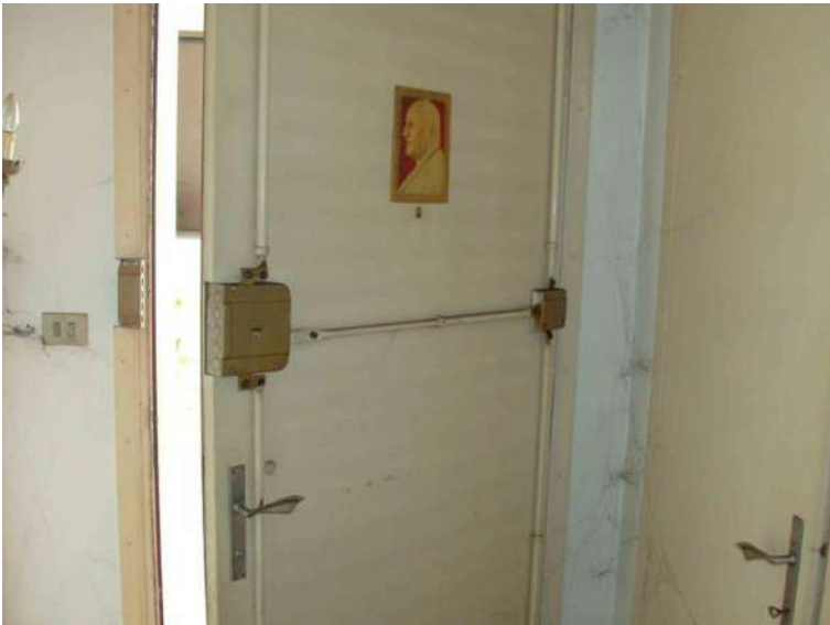
Veduta porta ingresso alloggio con chiusura metallica aggiuntiva a vista.
