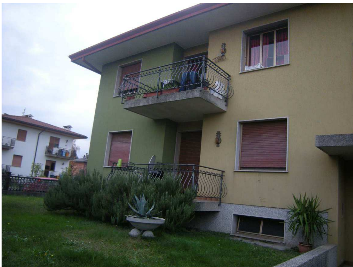
Aviano, Via B. Buozzi 5 - Il prospetto a sud- est dell'edificio.
