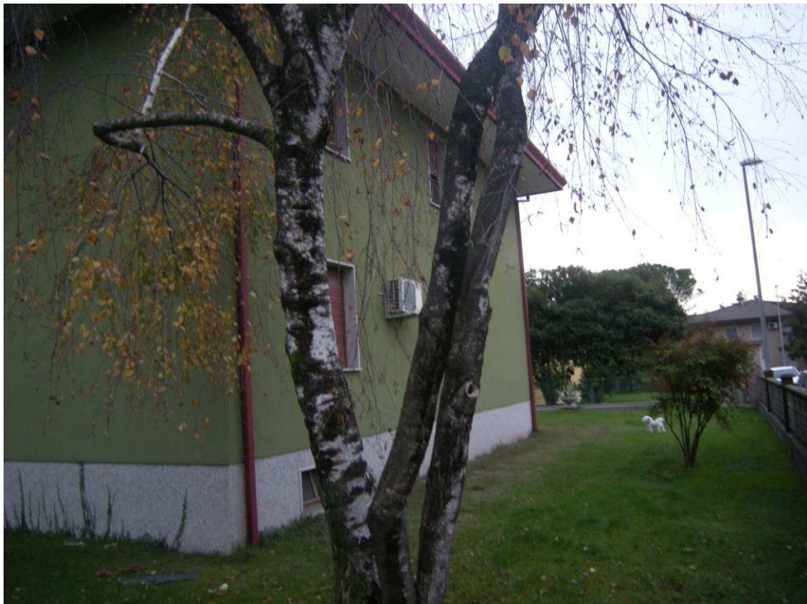
Aviano, Via B. Buozzi 5 - Il prospetto dell'edificio su via Buozzi.
