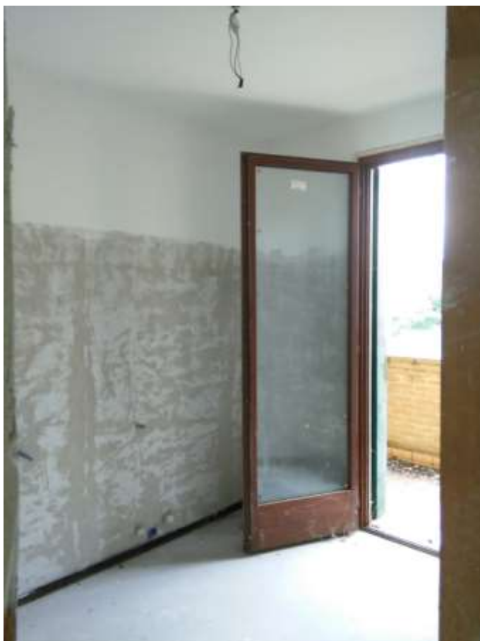
FOTO 16_PIANO PRIMO_BAGNO PRINCIPALE
