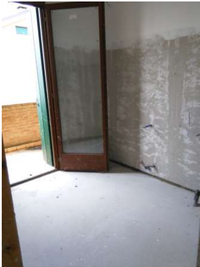
FOTO 16_PIANO PRIMO_BAGNO PRINCIPALE
