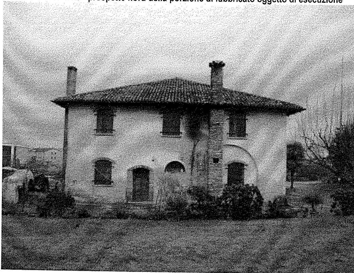
Foto 1.12 – prospetto nord della porzione di fabbricato oggetto di esecuzione
