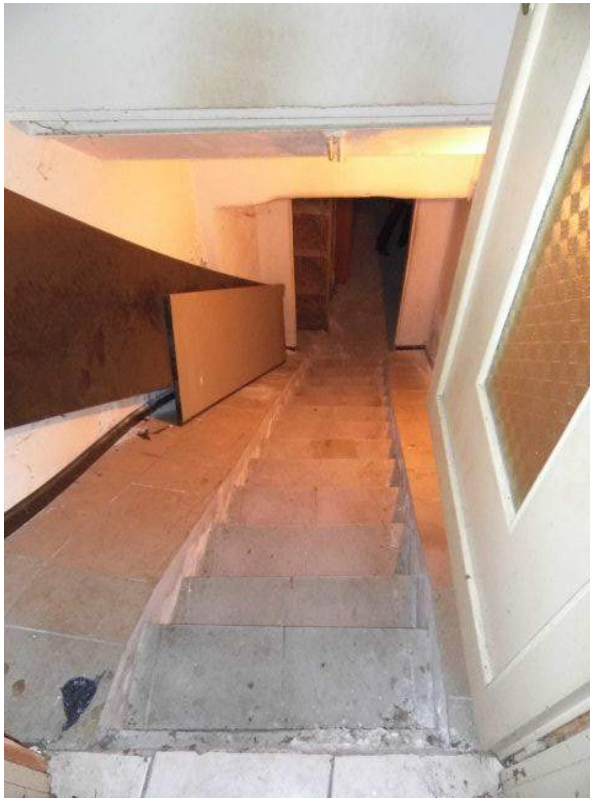
Foto n. 14: scala piano interrato
