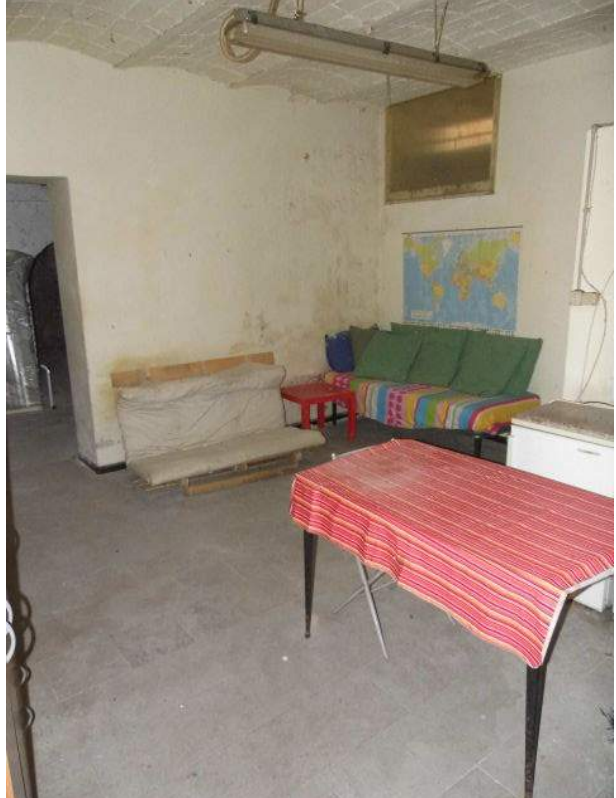
Foto n. 15: vista vano 1 – piano interrato
