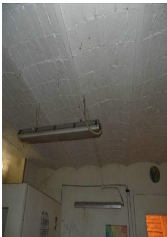
Foto 19: particolare soffitto vano 1 a volticine
