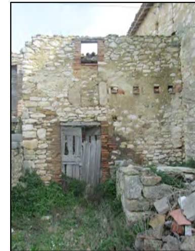
VISTA ESTERNA H
