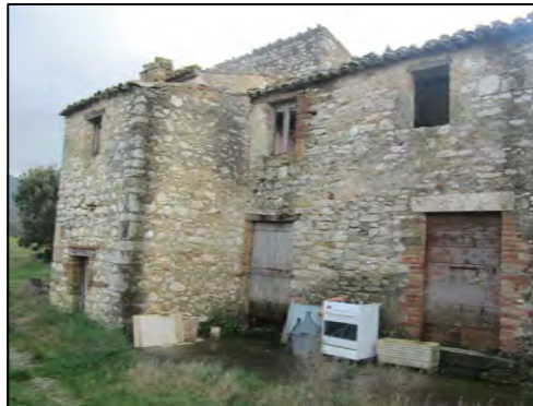
VISTA ESTERNA E
