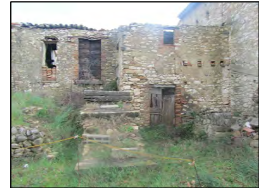
VISTA ESTERNA O
