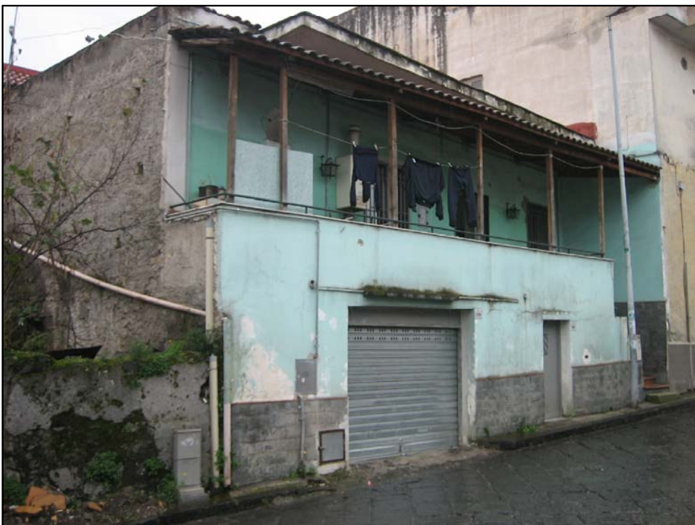
FOTO N. 2: immobile sito in San Giuseppe Vesuviano, NA alla via Santa Maria La Scala, n.283 (ex 215).
