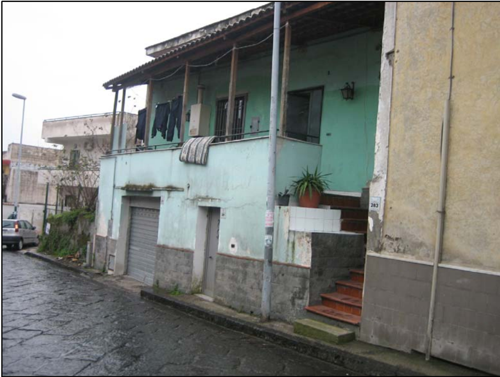
FOTO N. 1: immobile sito in San Giuseppe Vesuviano, NA alla via Santa Maria La Scala, n.283 (ex 215).
