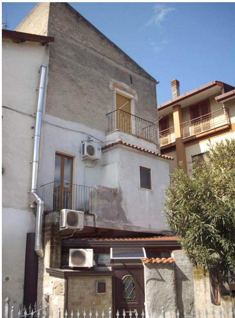
Foto 2 : Vista esterna immobile lato posteriore
