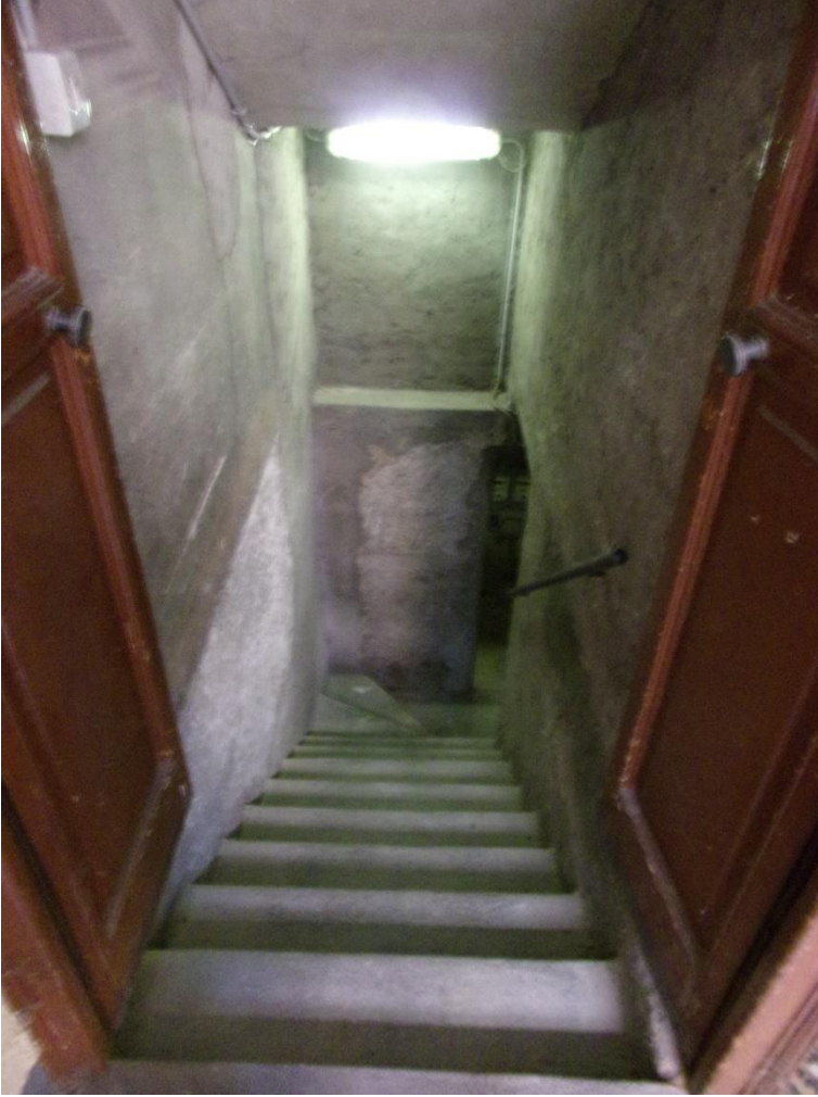
Foto 19: scala condominiale verso piano cantina
