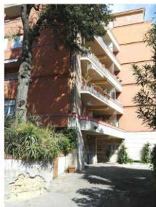
Foto n. 2 - Ingresso al fabbricato in cui si dice l'immobile pignone - Scala B
