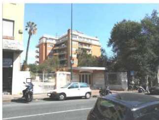
Foto n. 1 - Ingresso al condominio da via Manzoni
