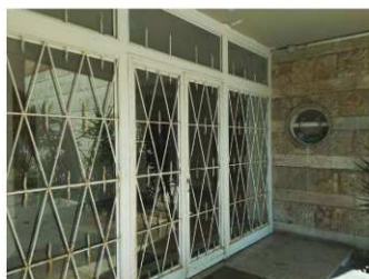
Foto n. 3 - Ingresso alla scala B
