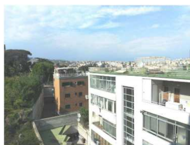
Foto n. 16 - Balcone 1 - Veduta esterna
