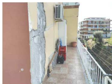
Foto n. 19 - Balcone 1 lato nord
