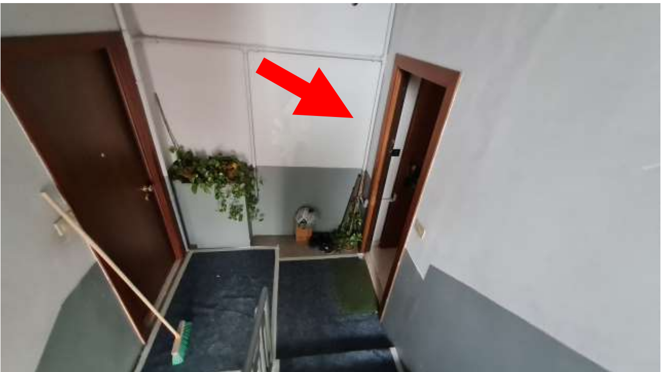
Ballatoio piano secondo
