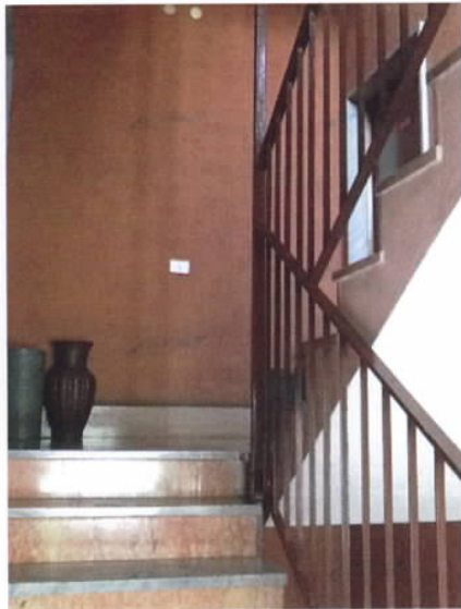
Vano scala condominiale
