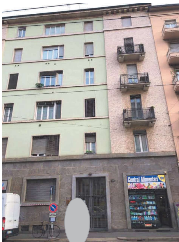
VISTA FABBRICATO SU VIA PONTE SEVESO
