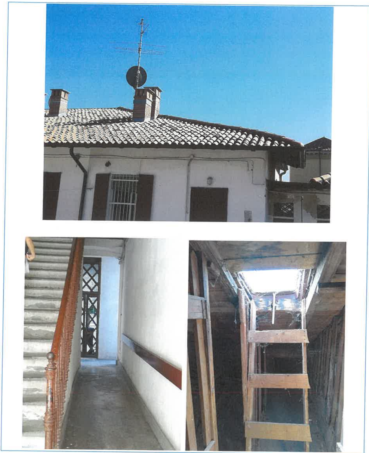
Vista del solaio di pertinenza, scala comune di accesso e vista interno
