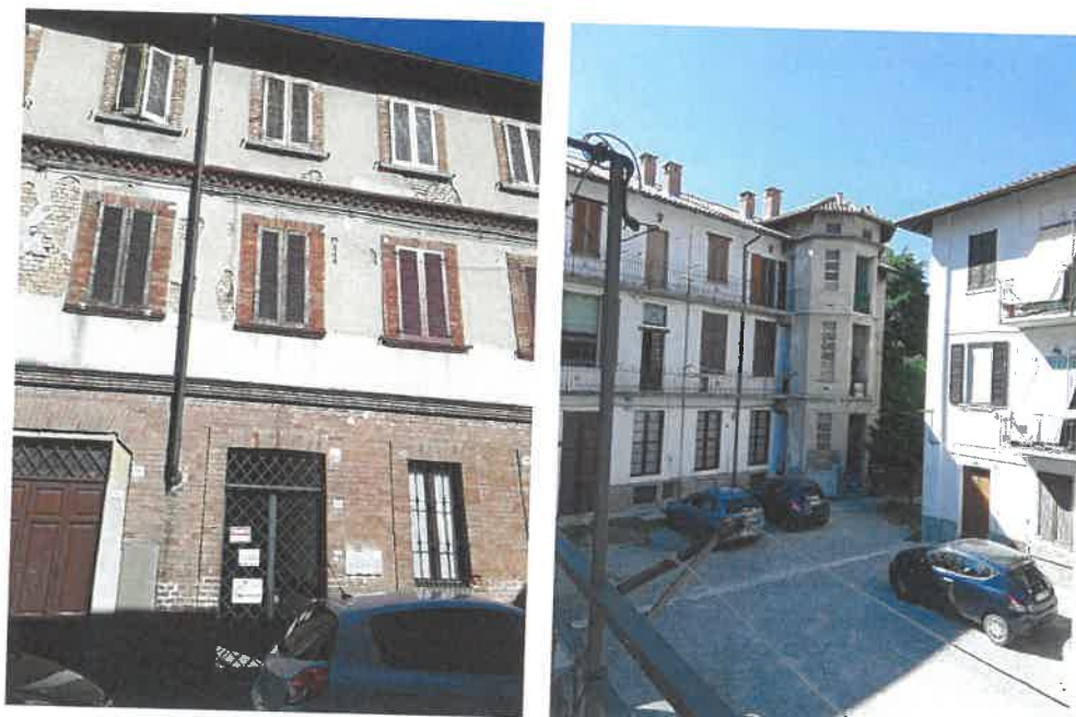
Fig. 3 - 4: accesso da via XI Febbraio, vista della corte S. Giuseppe lato XI Febbraio
