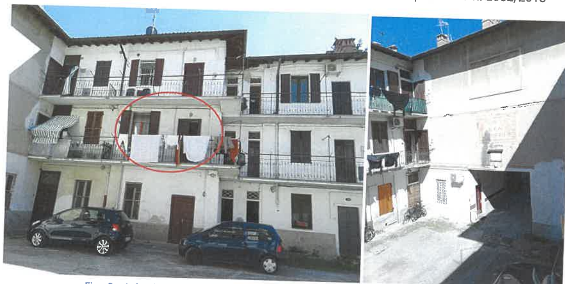
Fig. 5 - 6: individuazione immobile, vista della corte e accesso carrabile
