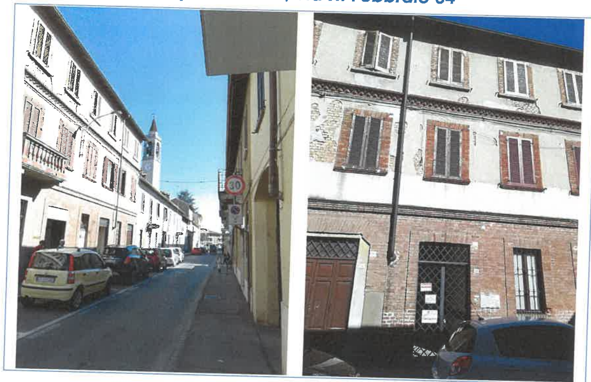
Vista del fabbricato, prospetto verso via XI Febbraio 34 - contesto
