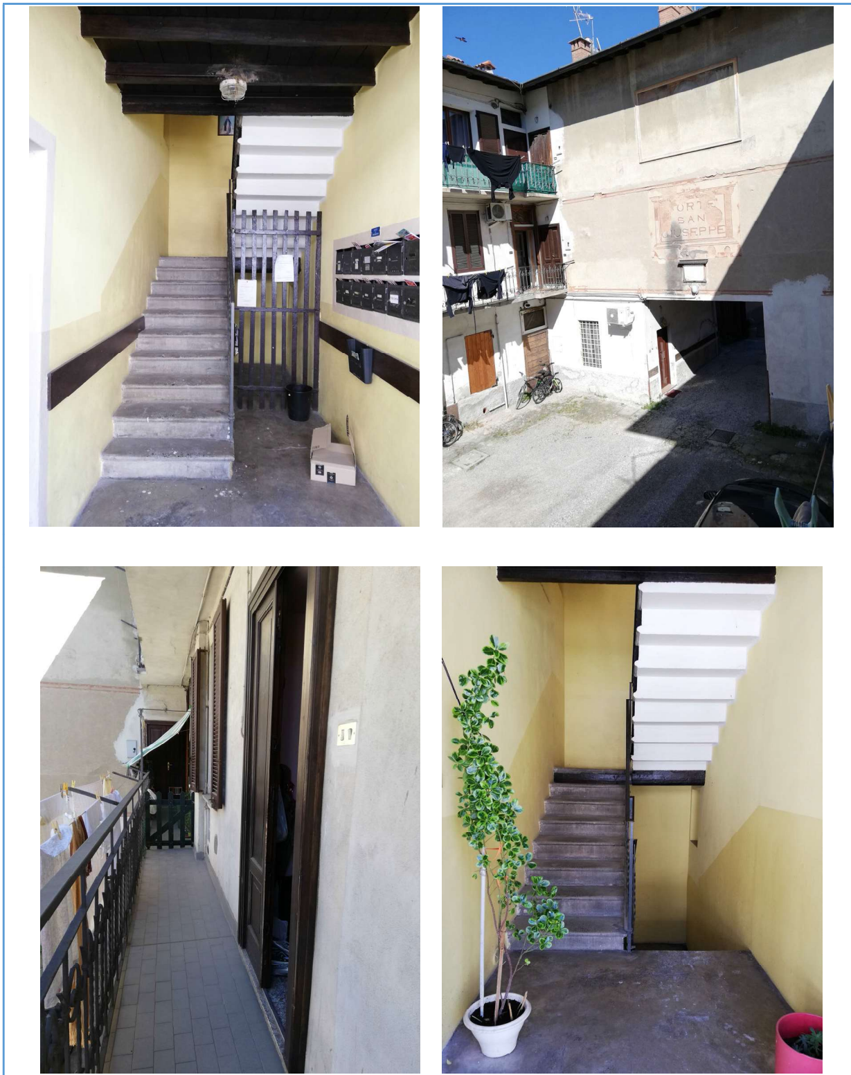
Vista della corte e parti comuni (scala accesso appartamento e ballatoio)
