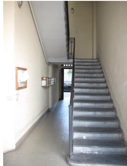
interno fabbricato – ingresso e scala p. T
