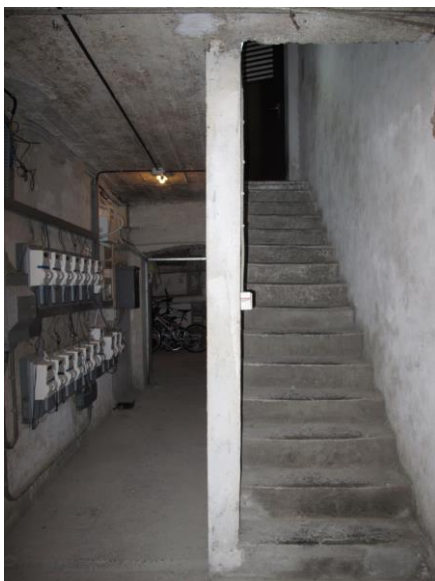
interno fabbricato – cantinato
