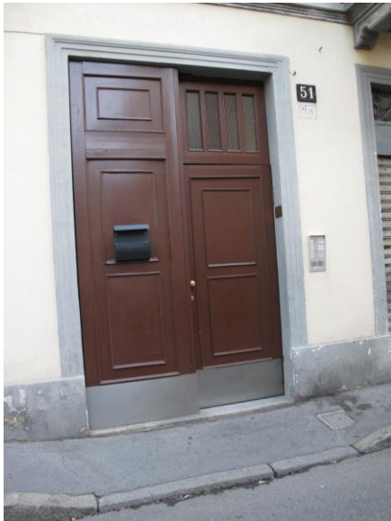
esterno fabbricato – ingresso
