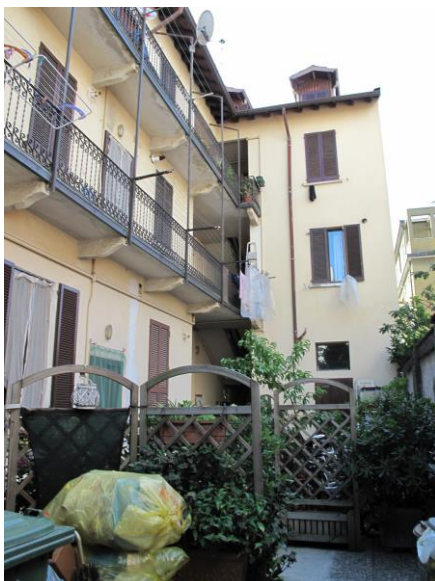
esterno fabbricato e cortile
