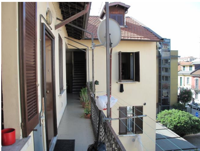
esterno fabbricato – ballatoio p. 2
