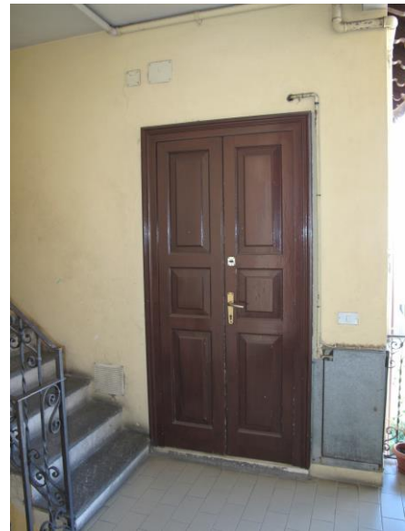
interno fabbricato – ingresso appartamento
