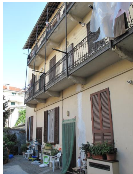
esterno fabbricato e cortile
