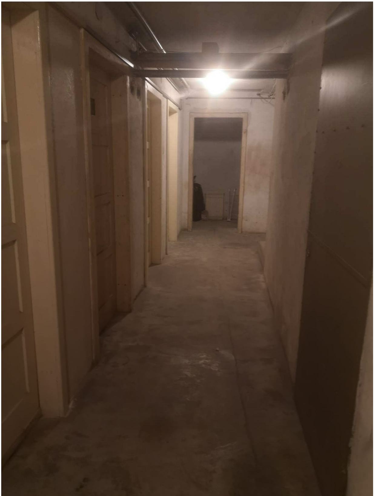
Foto 29 – vista corridoio cantine
