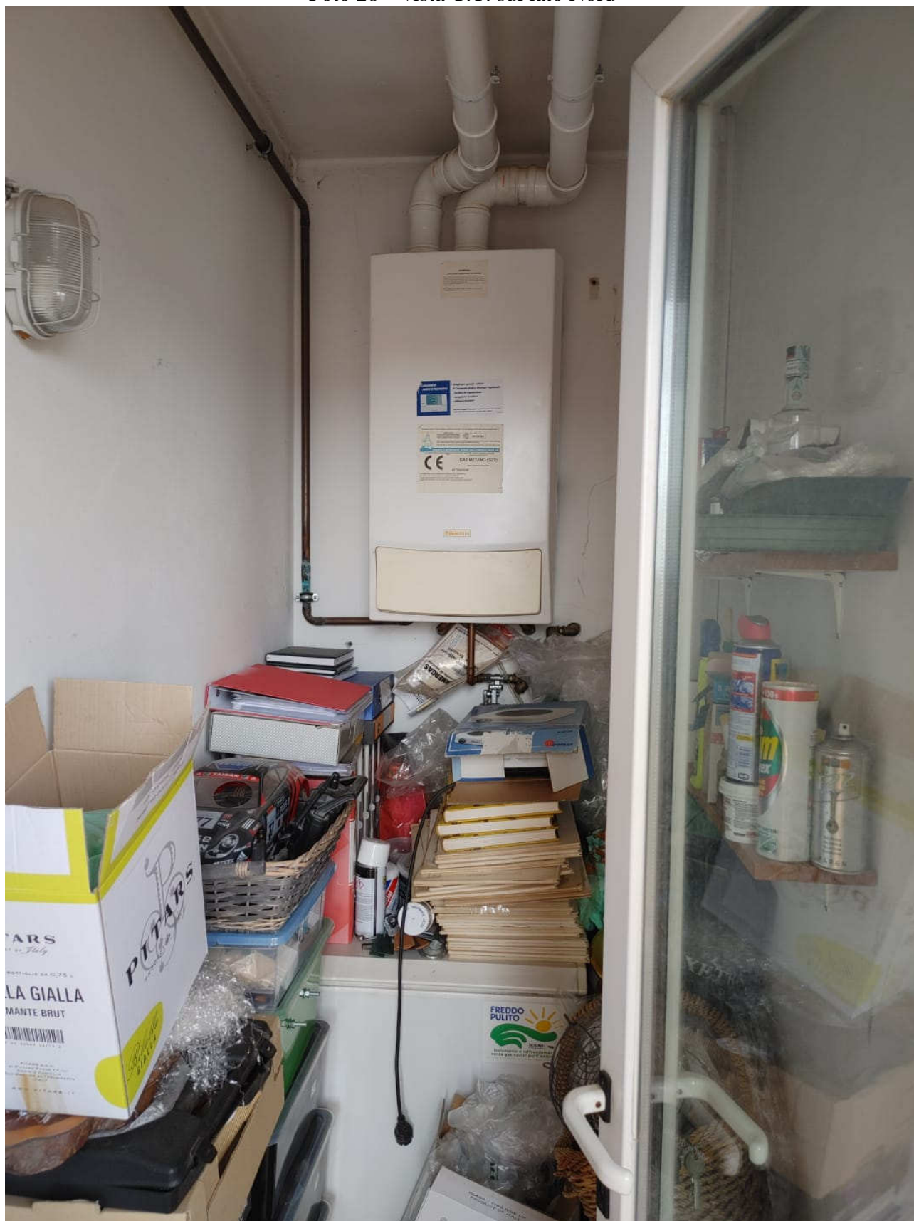
Foto 28 – vista C.T. sul lato Nord
