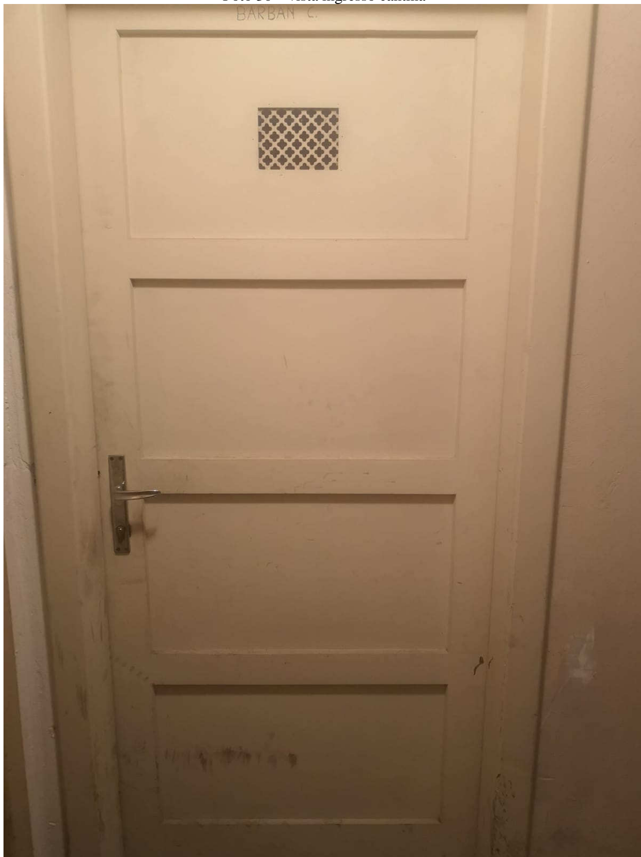
Foto 30 – vista ingresso cantina
