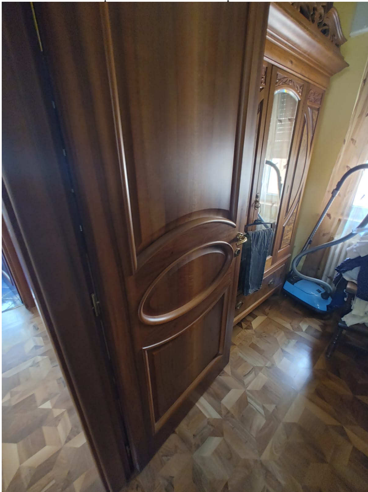
Foto 19 – vista porte interne in noce massiccio e pavimenti in noce e rovere
