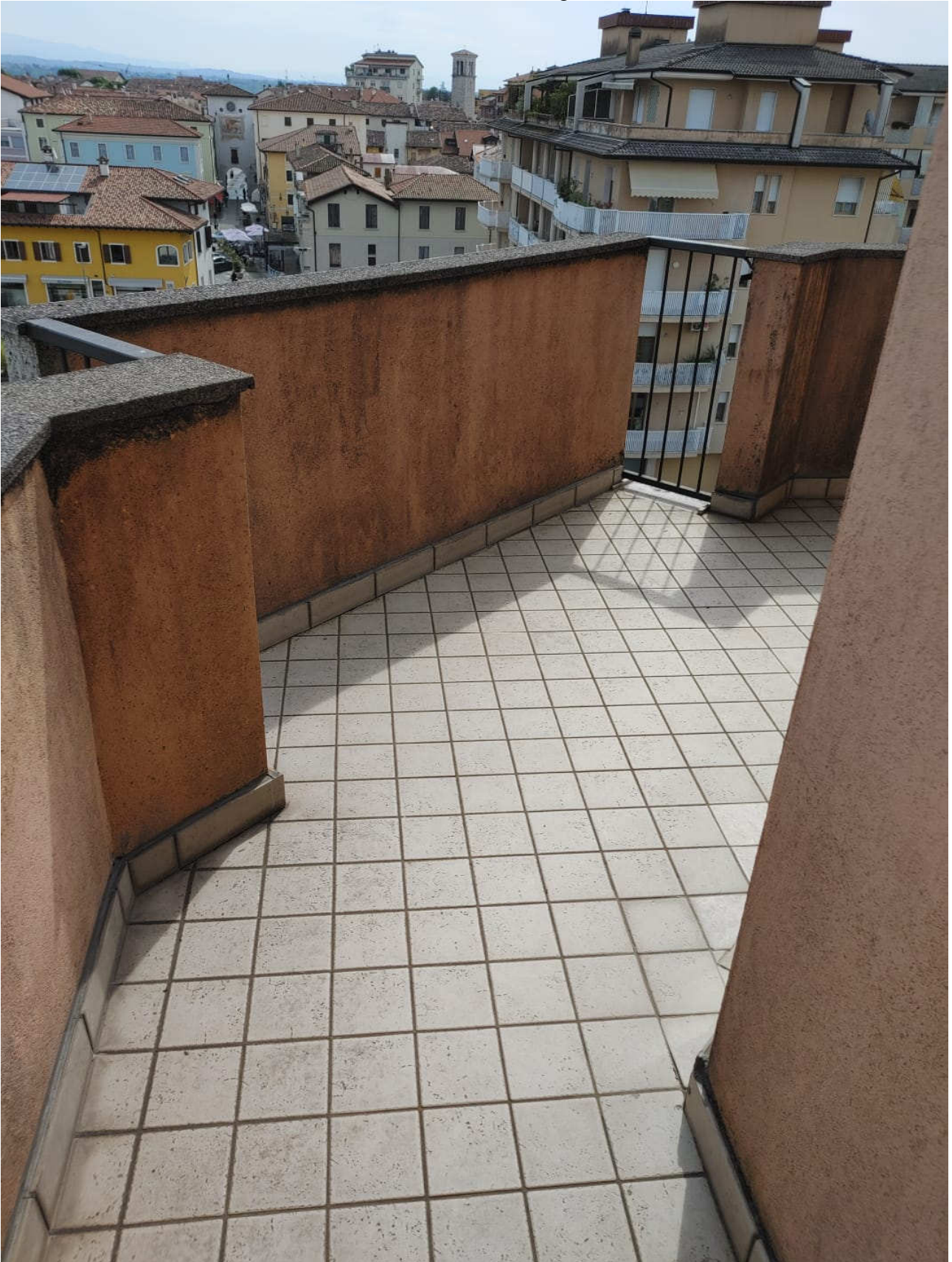
Foto 26 – vista terrazzo lato angolo nord/est
