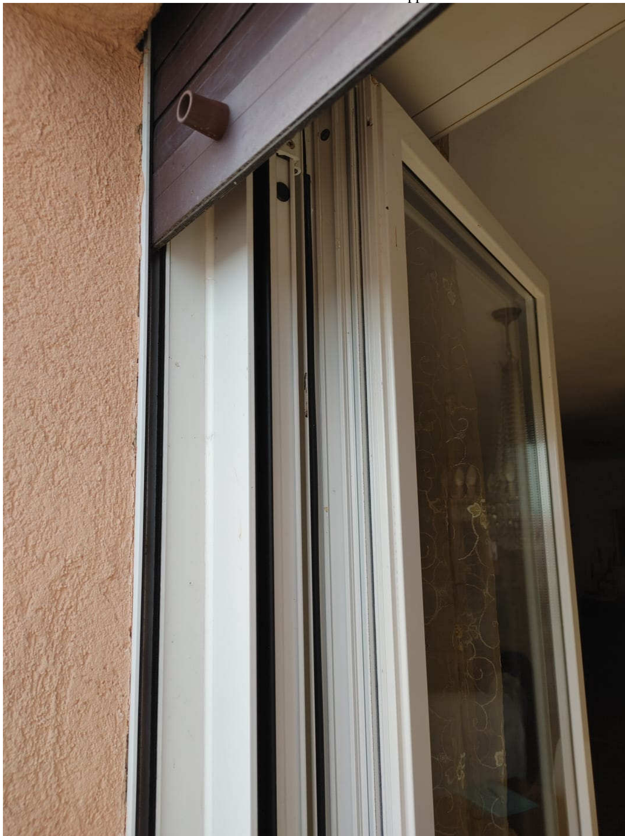
Foto 25 – vista serramenti in alluminio con tapparella in PVC
