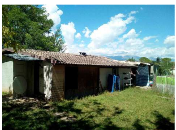
Veduta corpi precari/abusivi da rimuovere LOTTI 1) - 2)
