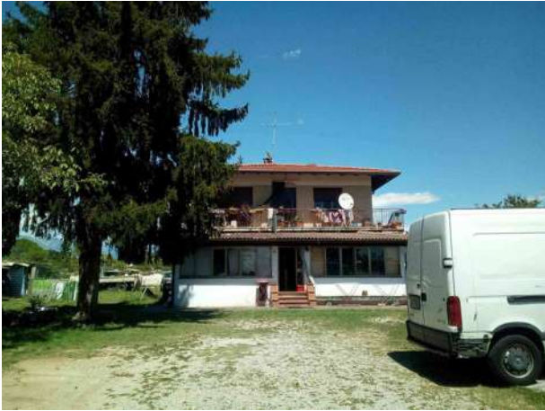
Veduta esterna da corte interna LOTTI 1) - 2)
