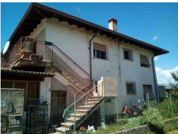
Particolare scala per accesso al piano primo - LOTTO 2)
