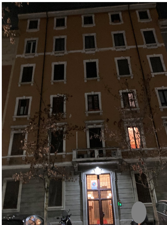
Foto n. 1: Prospetto principale su Via Seprio
