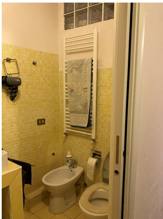
Foto n. 8: Servizio – particolare sanitari
