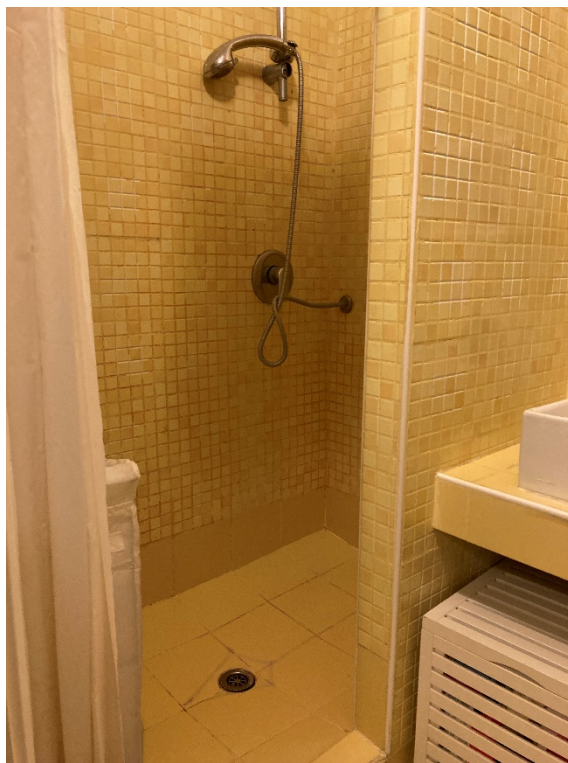
Foto n. 7: Servizio – particolare doccia
