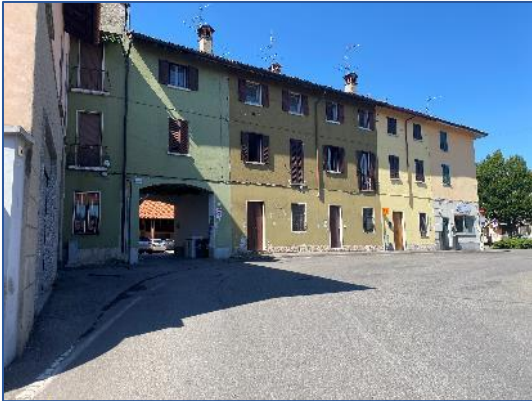
Foto 1 - ingresso comune da strada
