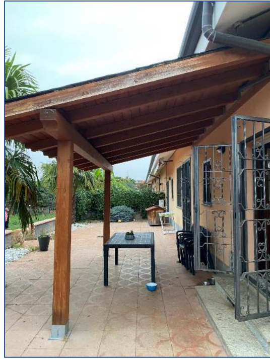
Foto 40 - tettoia su giardino esclusivo
