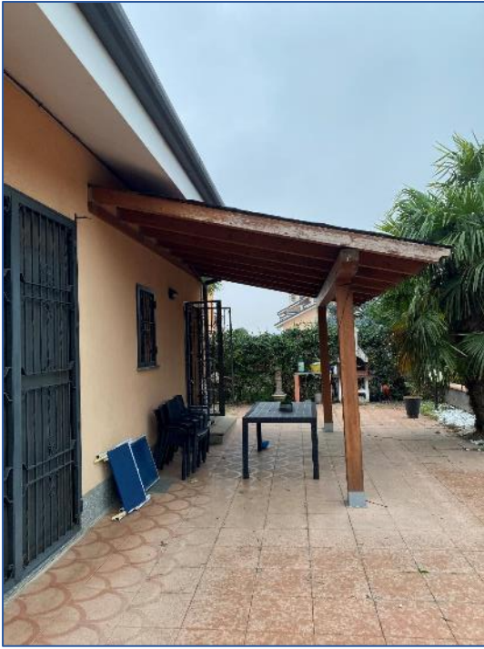
Foto 39 - tettoia su giardino esclusivo
