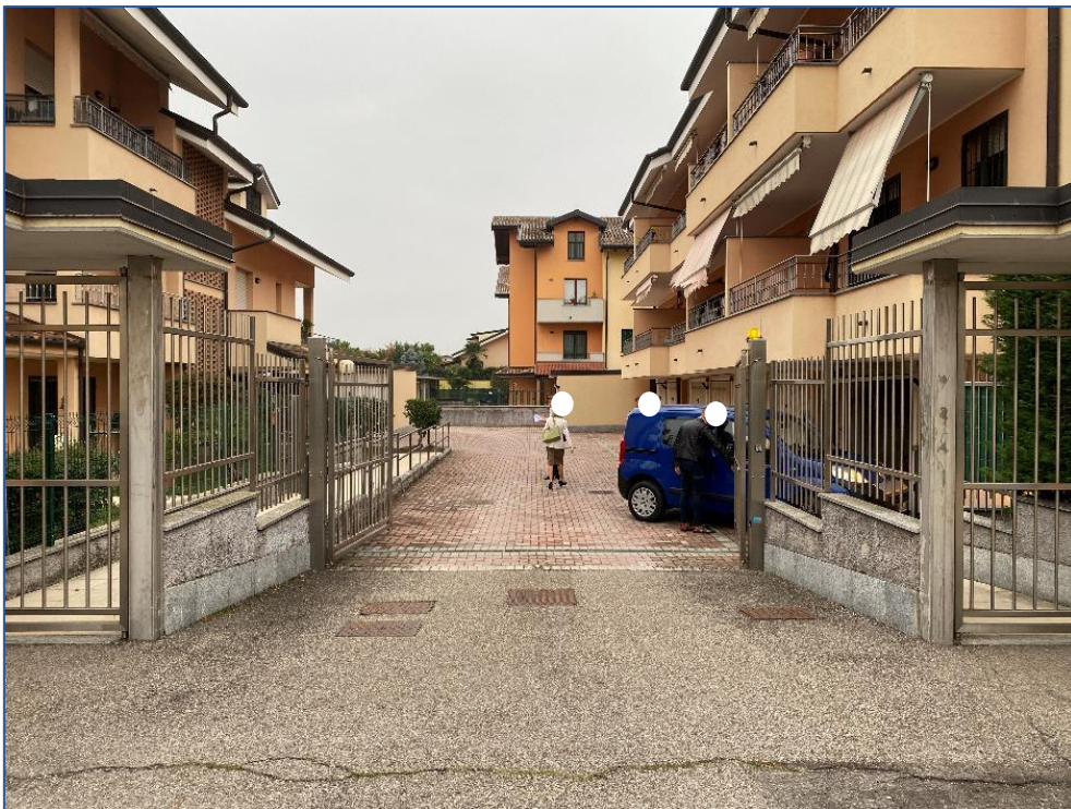
Foto 6 -ingresso comune da via Isonzo n. 26A
