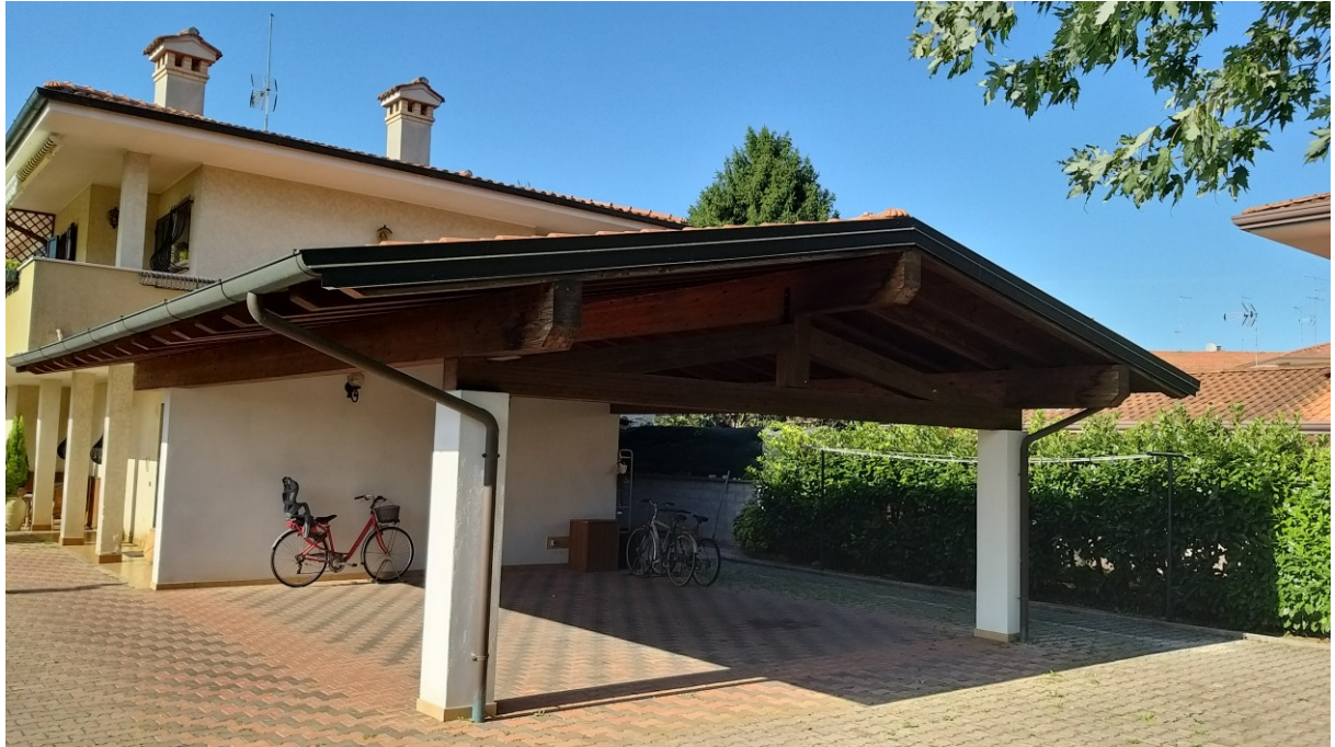
Foto n° 7 – Lotto 1 - Comune di Azzano Decimo (PN) – Foglio 19, m.le 496 sub 3. Veduta della tettoia da posizione sud-ovest.
