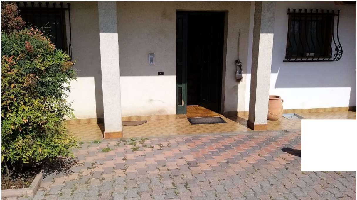
Foto n° 6 – Lotto 1 - Comune di Azzano Decimo (PN) – Foglio 19, m.le 496 sub 3. Particolare del porticato e dell'ingresso principale dell'abitazione.
