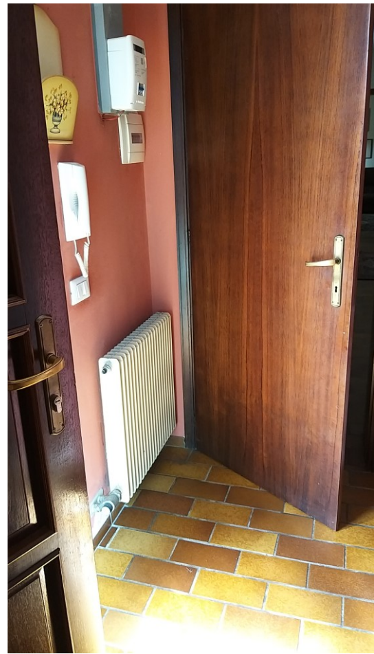
Foto n° 18 - Lotto 1 - Comune di Azzano Decimo (PN) - Foglio 19, m.le 496 sub 3 - Veduta interna dell'atrio di cui alla foto precedente. In questo vano si trova anche il contatore elettrico.
