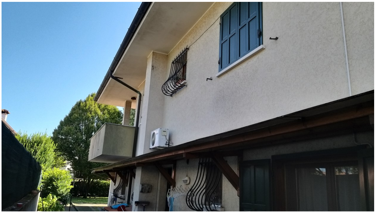
Foto n° 11 – Lotto 1 - Comune di Azzano Decimo (PN) – Foglio 19, m.le 496 sub 3. Veduta, da posizione nord-est, di parte del primo piano e della terrazza.
