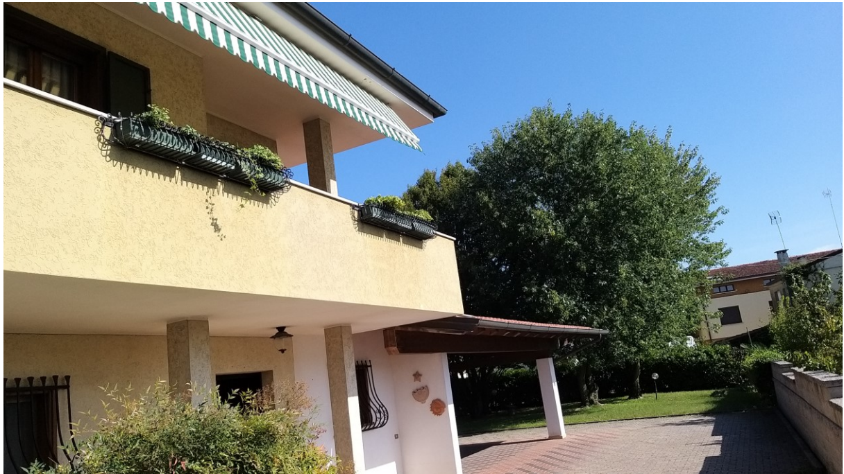
Foto n° 3 – Lotto 1 - Comune di Azzano Decimo (PN) – Foglio 19, m.le 496 sub 3 – Particolare, da posizione nord-ovest, di parte del villino e della tettoia posta a sud; sullo sfondo si trova l'area a giardino con il prato e alcune essenze ornamentali.
