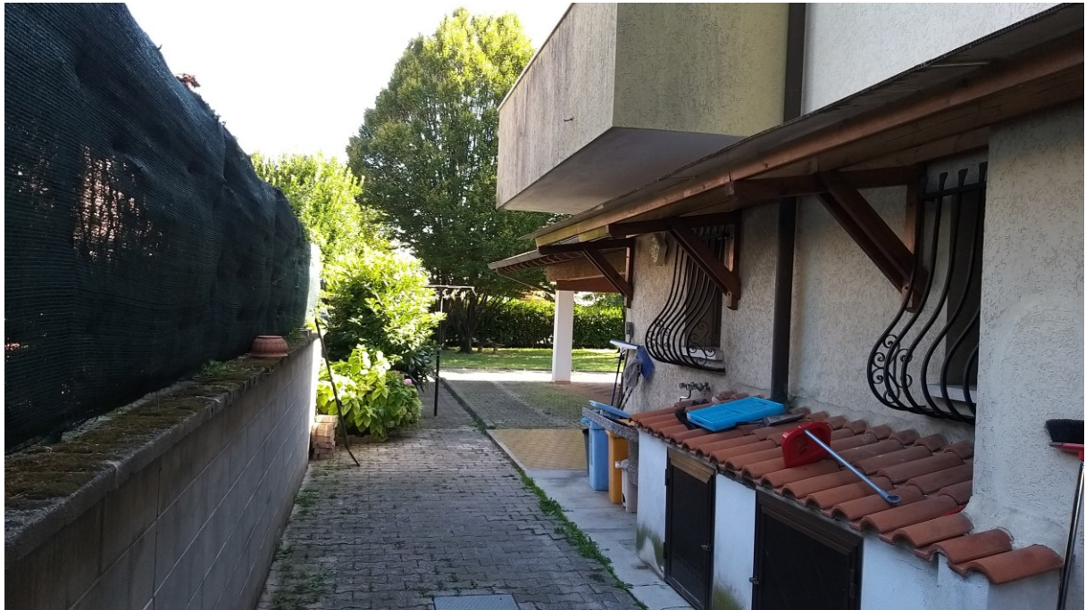
Foto n° 13 – Lotto 1 - Comune di Azzano Decimo (PN) – Foglio 19, m.le 496 sub 3. Veduta, da posizione nord-est, del piano terra in corrispondenza dei vani adibiti a centrale termica e lavanderia.
