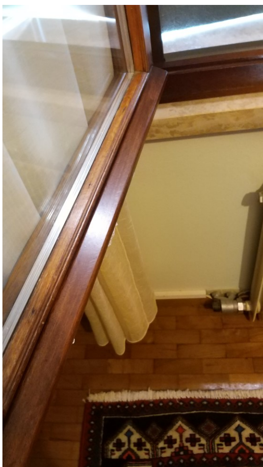
Foto n° 60 – Lotto 1 - Comune di Azzano Decimo (PN) – Foglio 19, m.le 496 sub 3 – Piano primo. Particolare dei serramenti nella camera di cui alla foto precedente.
