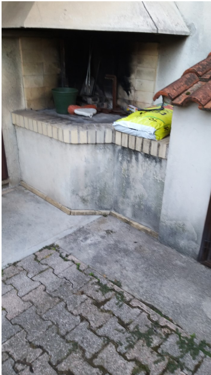
Foto n° 12 – Lotto 1 - Comune di Azzano Decimo (PN) – Foglio 19, m.le 496 sub 3. Particolare del caminetto esterno, posto a confine nord del compendio pignorato, nell'area adibita a barbecue.
