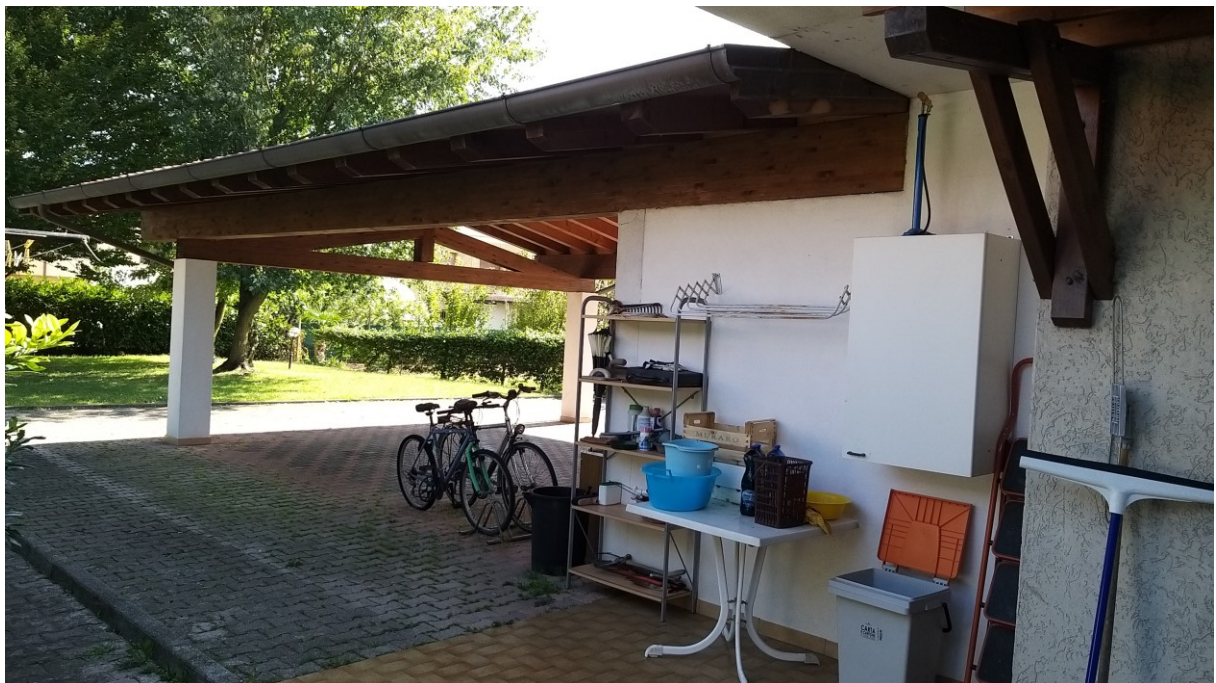
Foto n° 14 – Lotto 1 - Comune di Azzano Decimo (PN) – Foglio 19, m.le 496 sub 3. Particolare dell'ultimo tratto del piano terra e della tettoia; sullo sfondo il giardino.
