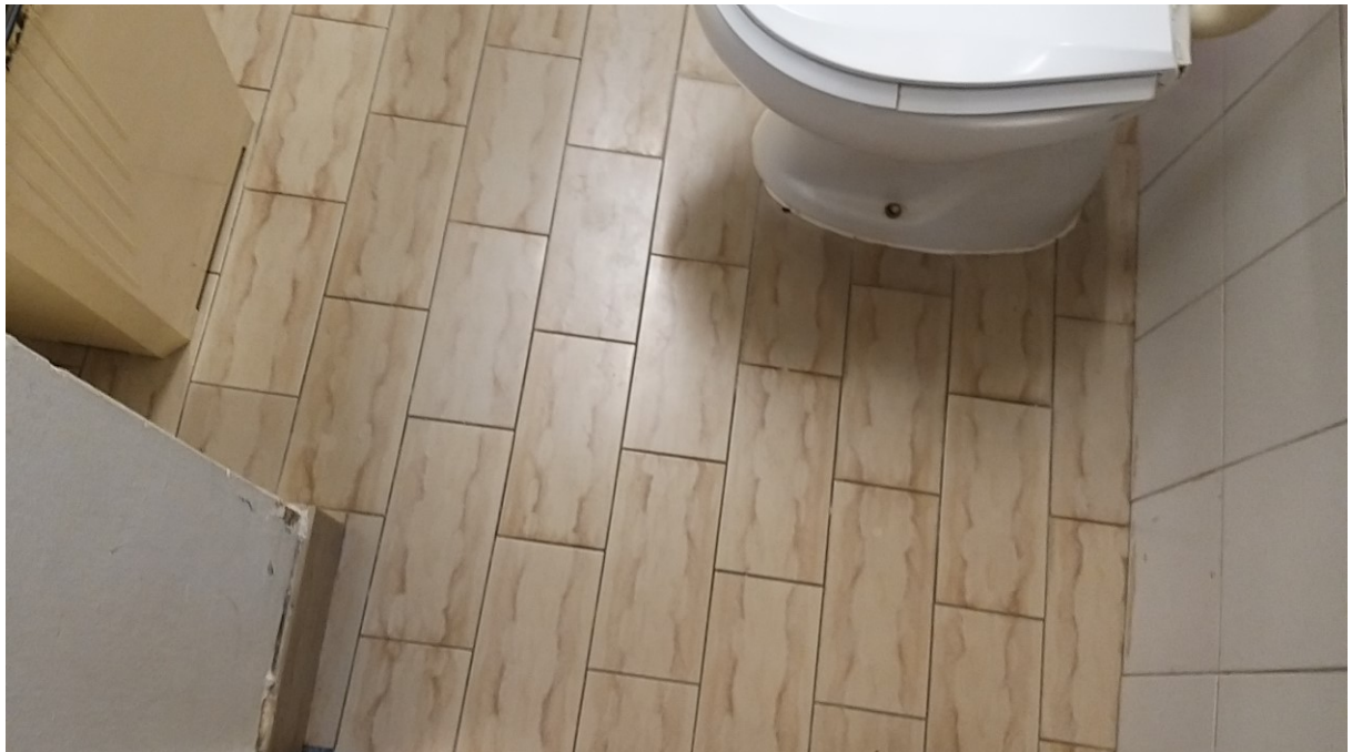
Foto n° 40 - Lotto 1 - Comune di Azzano Decimo (PN) - Foglio 19, m.le 496 sub 3 - Piano terra. Particolare della pavimentazione presente nel vano uso WC e centrale termica.
