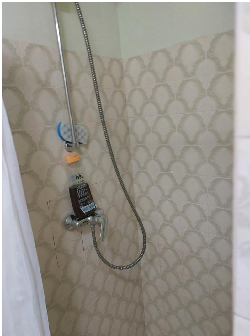
Foto n° 36 - Lotto 1 - 22-07-2022 - Comune di Sequals (PN) - Foglio 10 m.le 381 sub 1. Piano scantinato: particolare del box doccia all'interno dello stesso vano.
