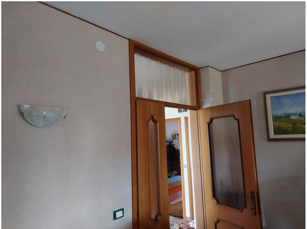
Foto n° 13 – Lotto 1 - 22/07/2022 - Comune di Sequals (PN) – Foglio 10 m.le 381 sub 1. Piano rialzato: particolare dell'accesso al soggiorno visto dall'interno.
