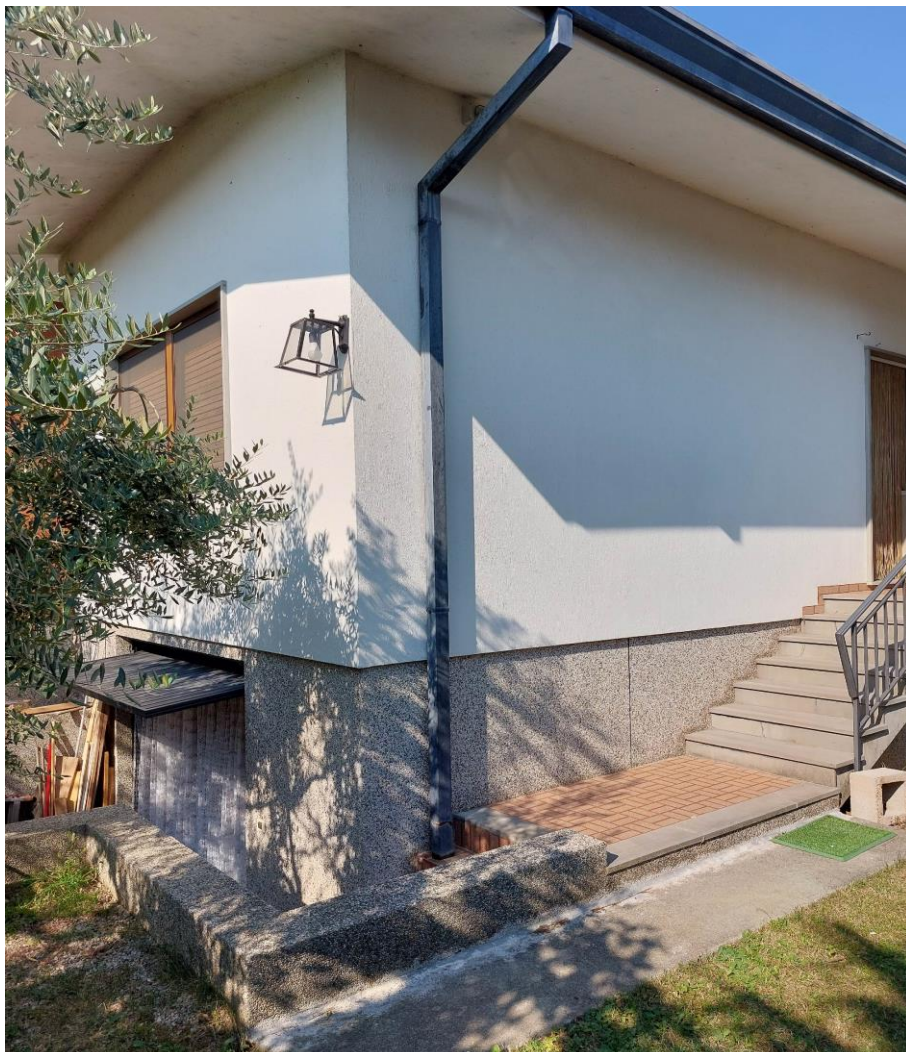
Foto n° 8–Lotto 1-22/07/2022-Comune di Sequals (PN)–Foglio 10 m.le 381. Particolare dell'accesso secondario al piano rialzato sul retro dell'abitazione.
