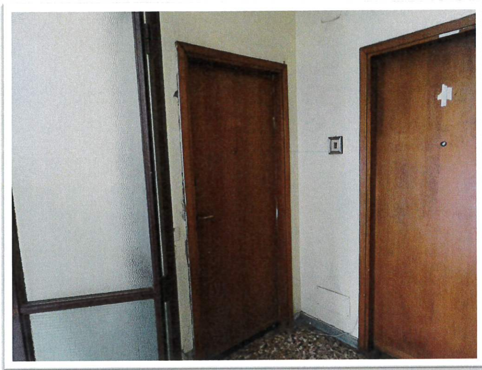
Particolare dell'ingresso e pianerottolo del 2° piano.
