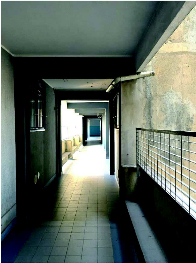
Vista ballatoio di disimpegno comune
