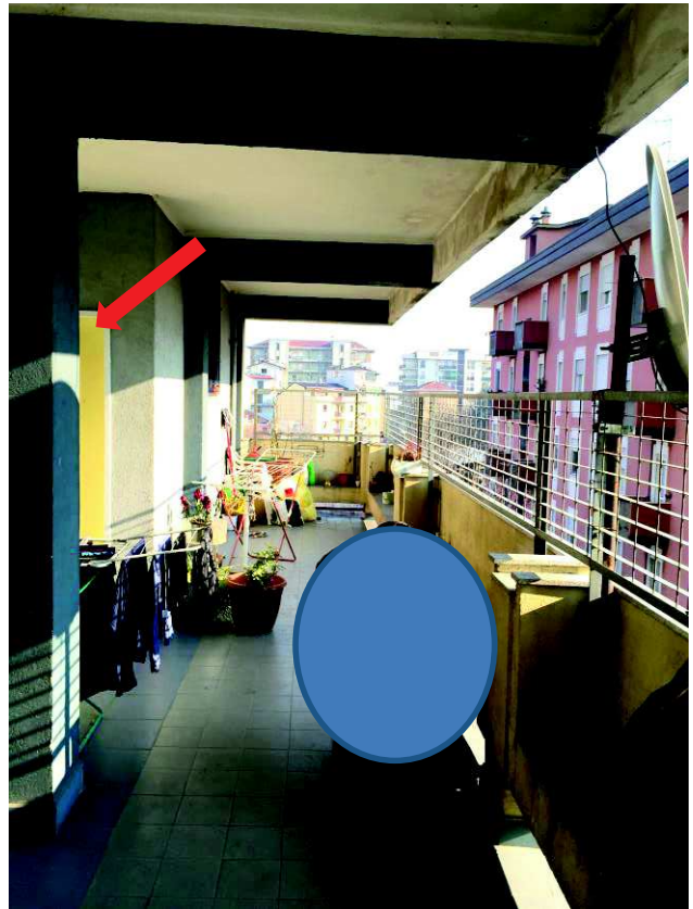
Vista ballatoio di accesso all'immobile
