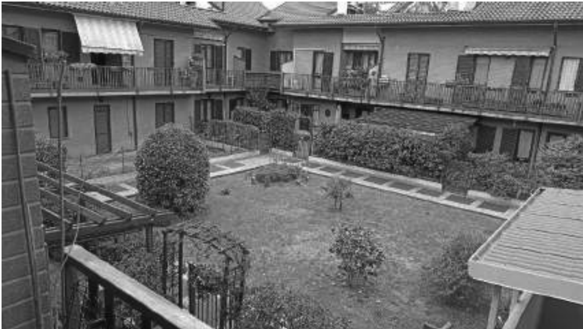
Foto n.21 – giardino pensile sopra box auto
