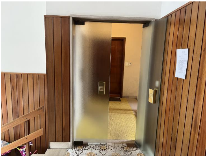
Androne di Ingresso condominiale/vano scale
