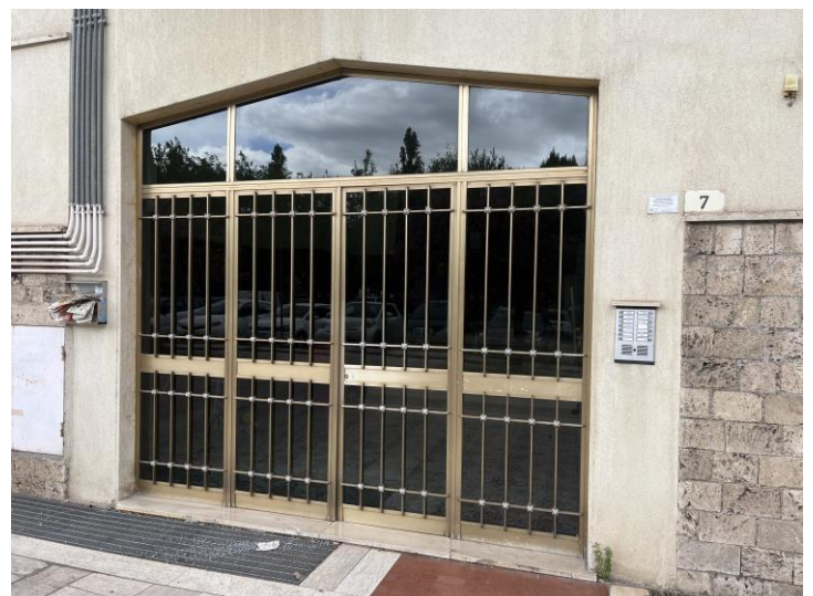
Portone di Ingresso condominiale
