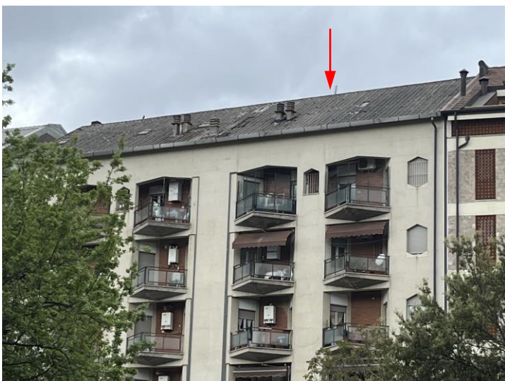
Particolare della copertura a tetto del Fabbricato/Condominio
