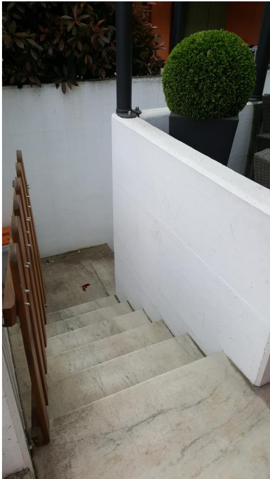
SCALA ESTERNA D'ACCESSO AI GARAGES
