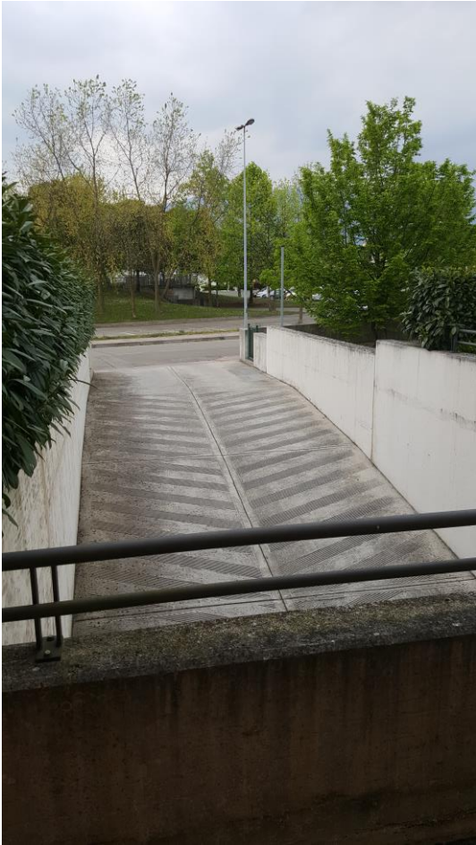
SCIVOLO D'ACCESSO AL PIANO INTERRATO
