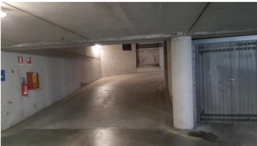
LA RAMPA VEICOLARE CHE CONDUCE AI PIANI INTERRATI
