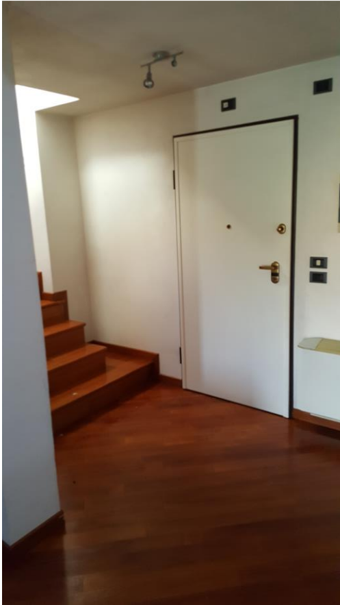
SCALA D'ACCESSO AL LASTRICO SOLARE
