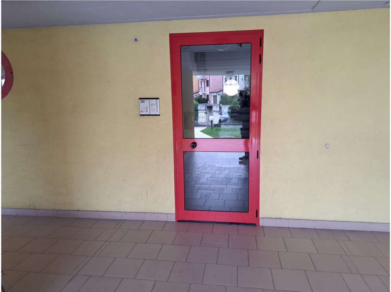
13 - accesso vano scala
