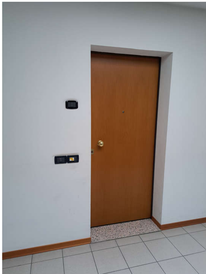
32 - ingresso da vano scala comune
