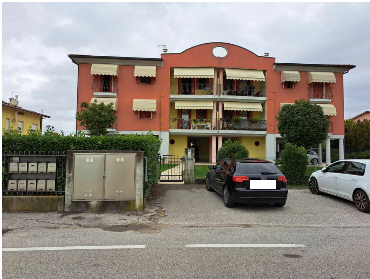
1 - fronte fabbricato accesso
