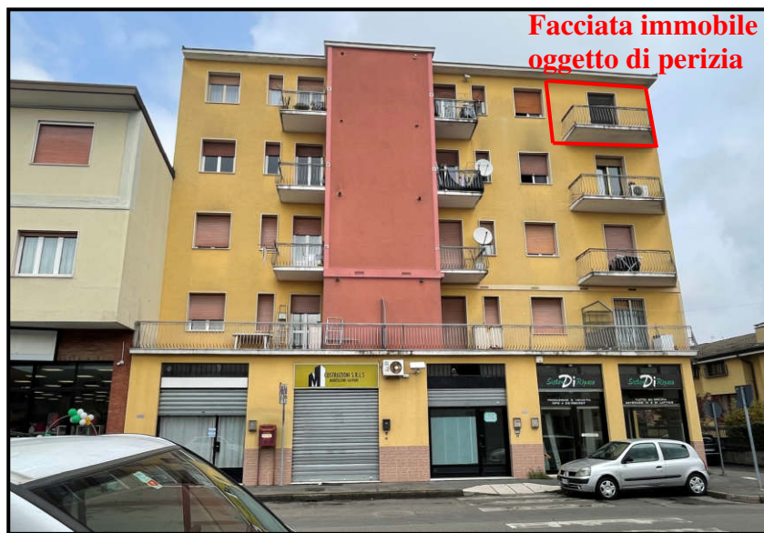
Vista da via S. Pellico
