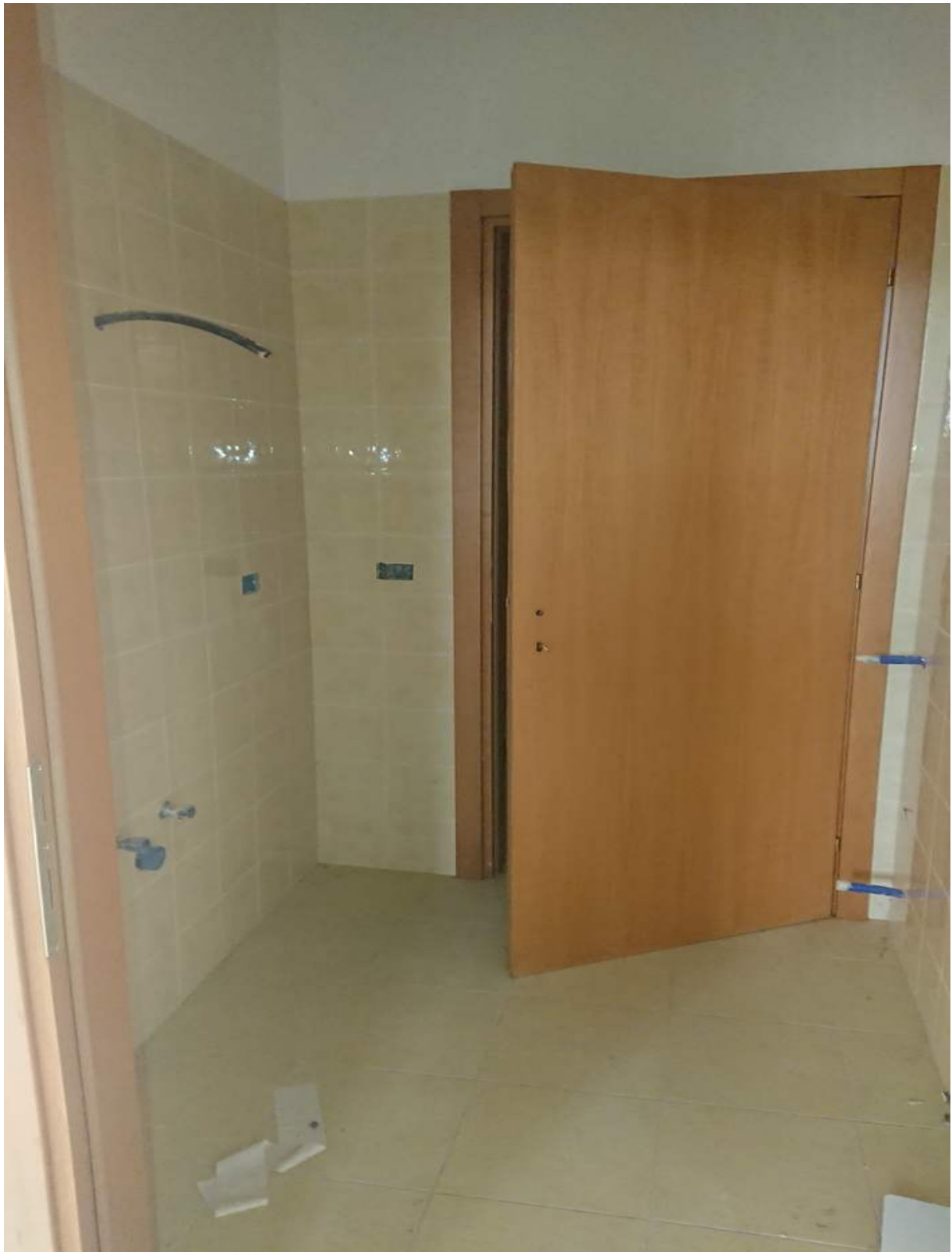
Foto n° 3 - 25/01/2022 - Comune di Pramaggiore, foglio 10, part.549, sub.32 – Antibagno.
