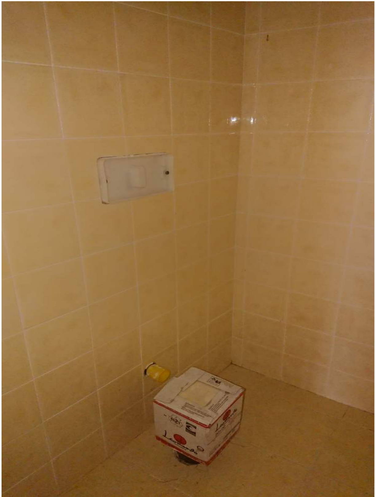
Foto n° 4 - 25/01/2022 - Comune di Pramaggiore, foglio 10, part.549, sub.32 – Wc
