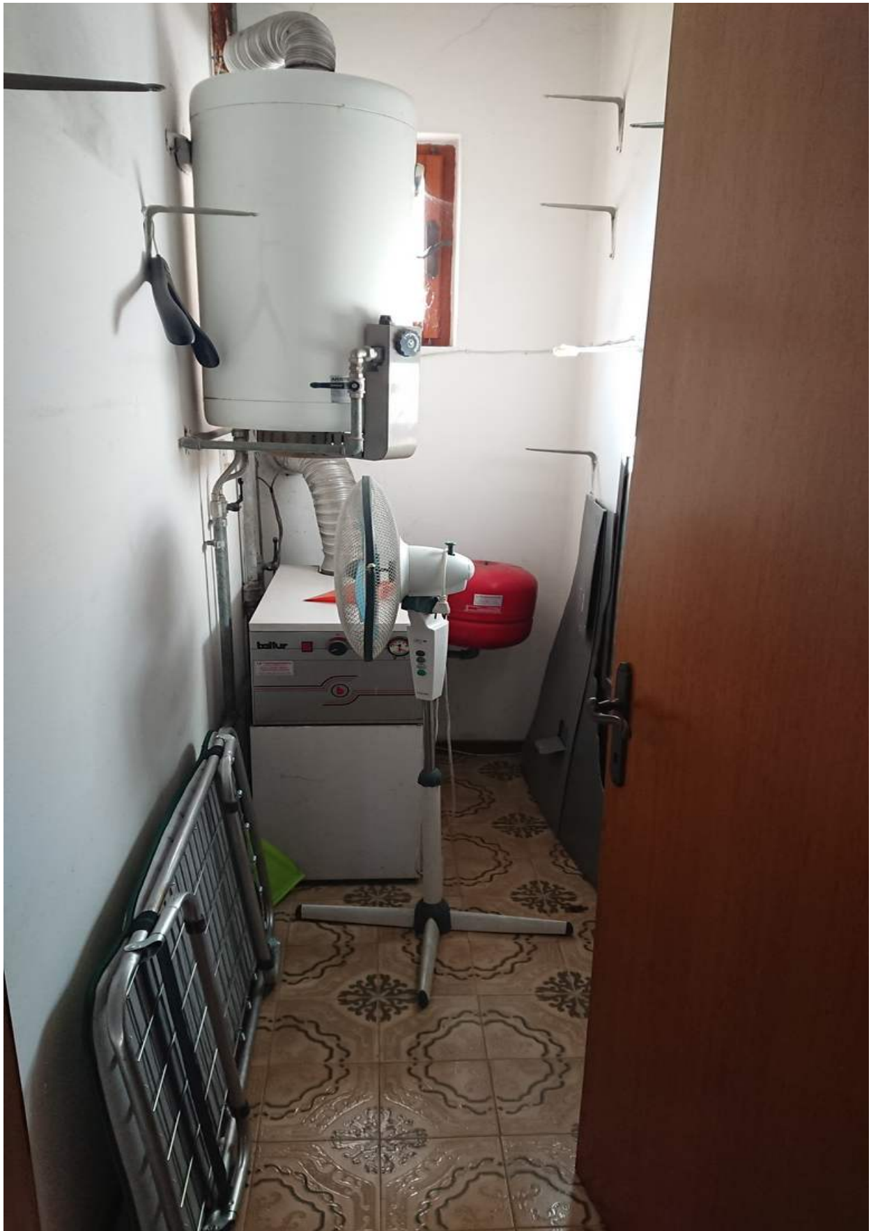
Foto n° 13 - 23/11/2021 - Comune di S.Stino di Livenza, foglio 14, part.163, sub.22 – Ripostiglio.
