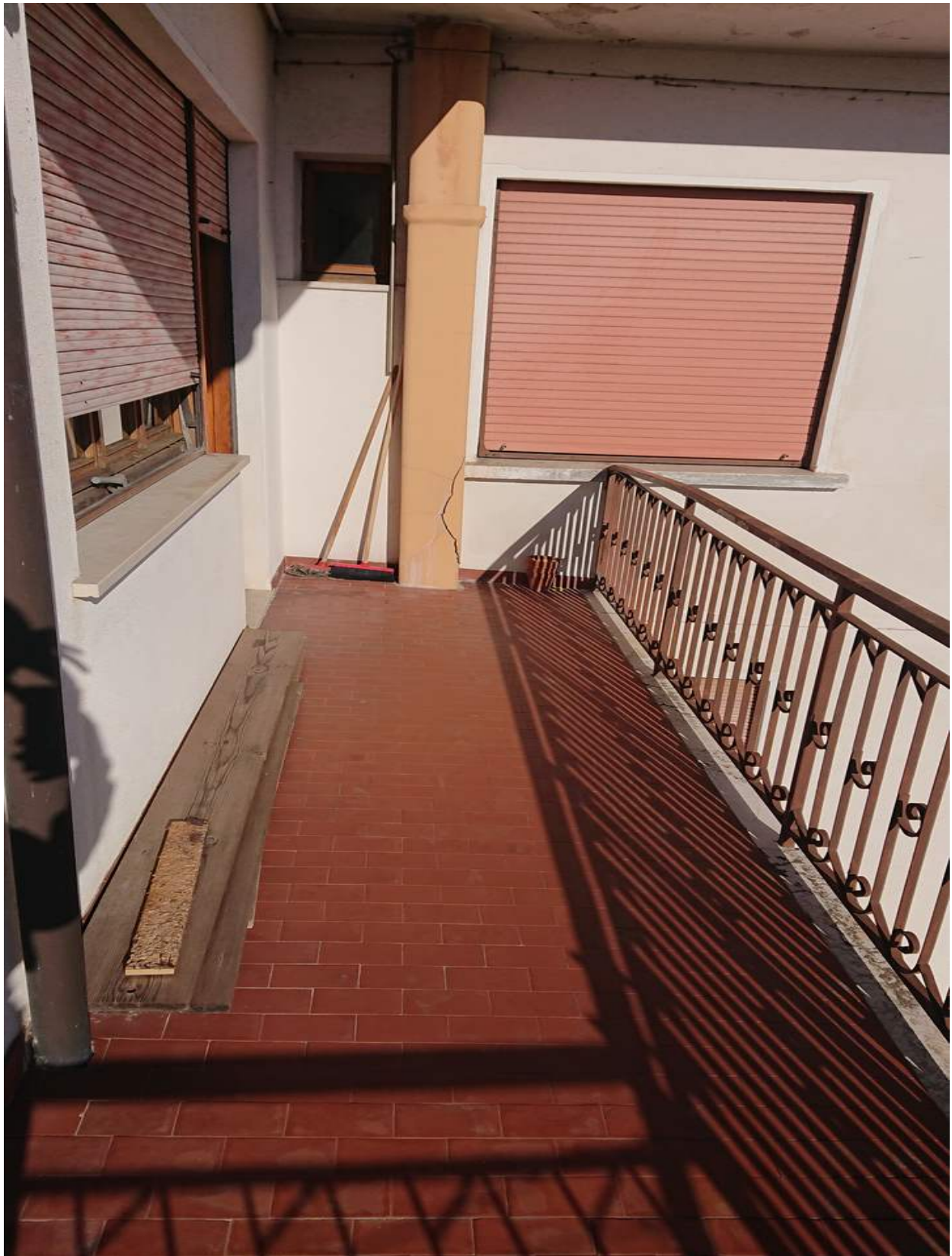
Foto n° 22 - 23/11/2021 - Comune di S.Stino di Livenza, foglio 14, part.163, sub.22 – Poggiolo.
