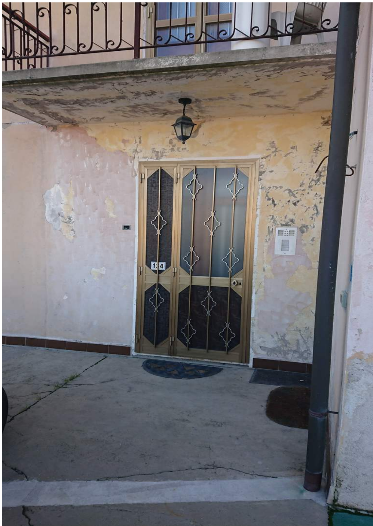
Foto n° 3 - 23/11/2021 - Comune di S.Stino di Livenza, foglio 14, part.163 – Portoncino di accesso al fabbricato.
