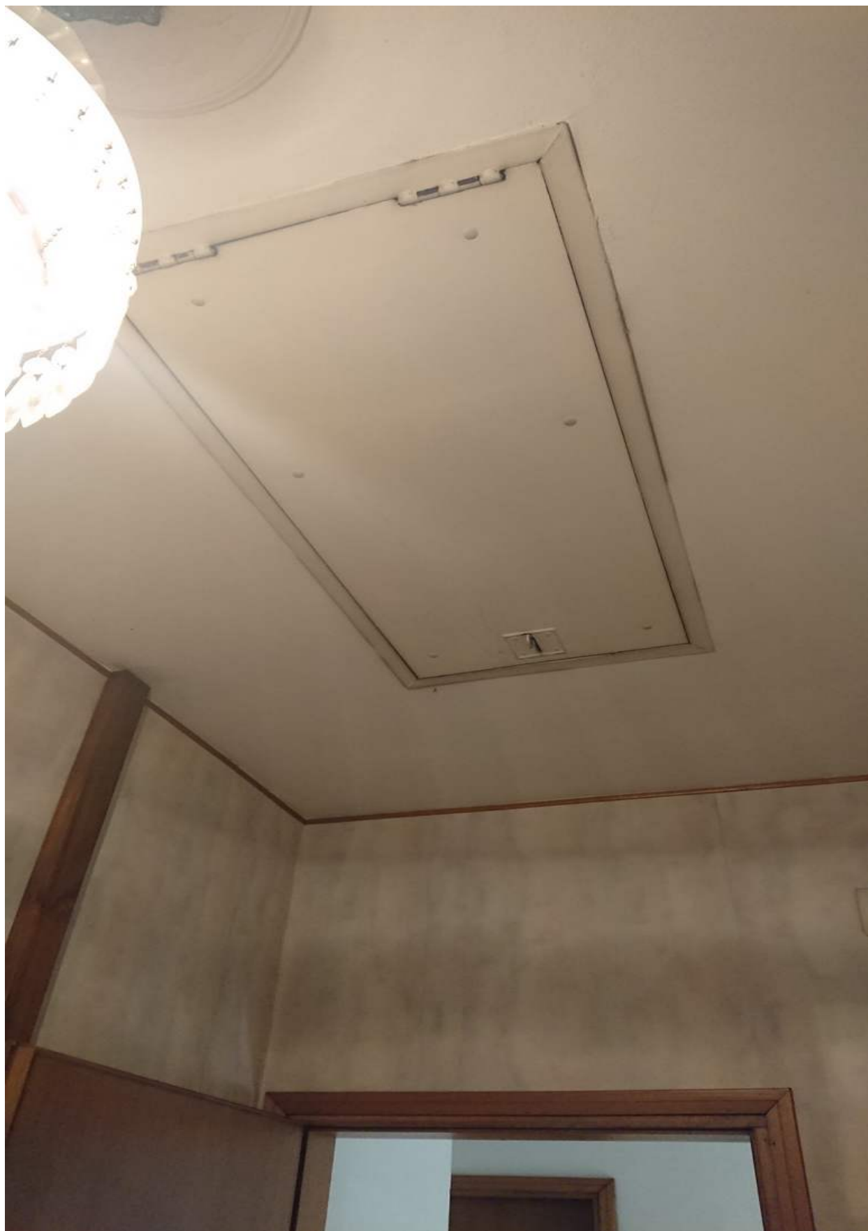
Foto n° 14 - 23/11/2021 - Comune di S.Stino di Livenza, foglio 14, part.163, sub.22 – Botola posta nel soffitto del corridoio di ingresso.
