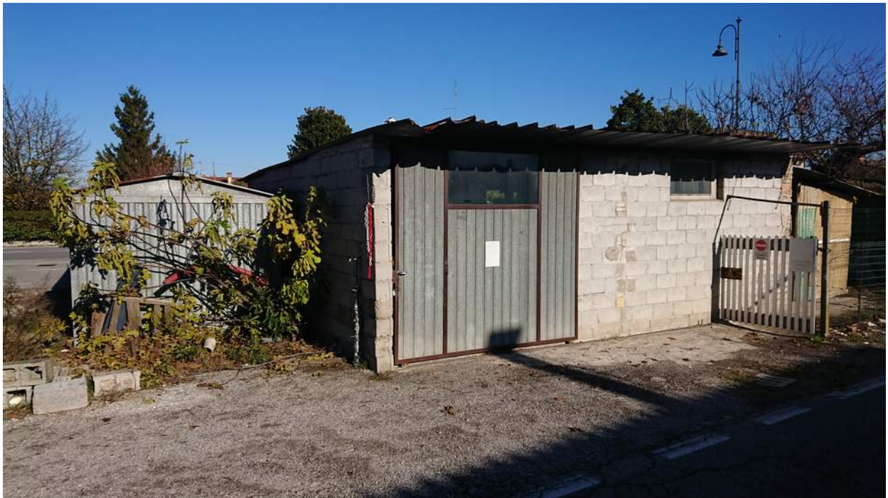
Foto n° 23 - 23/11/2021 - Comune di S.Stino di Livenza, foglio 14, part.163, sub.12-15 – Fabbricato costruito abusivamente sull'area di parcheggio.
