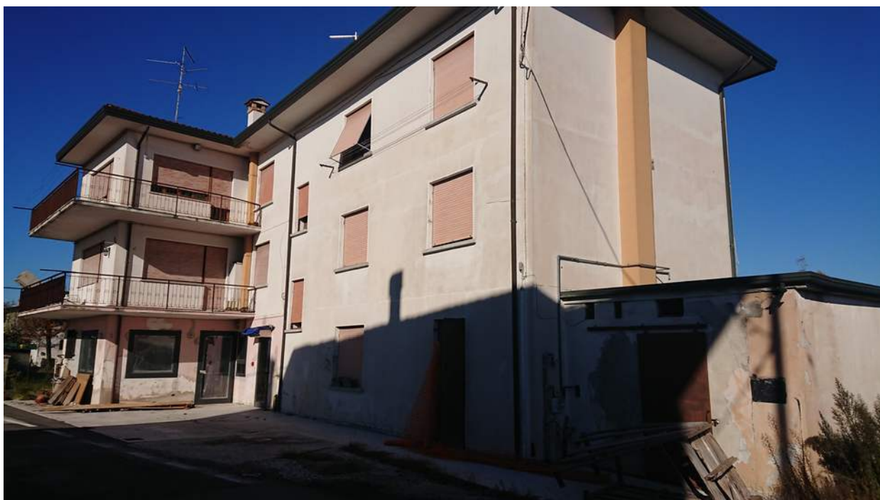
Foto n° 2 - 23/11/2021 - Comune di S.Stino di Livenza, foglio 14, part.163 – Visione esterna del fabbricato condominiale. Fotografia scattata da via Don Sturzo.
