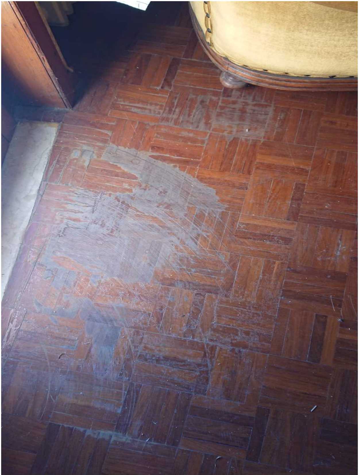
Foto n° 20 - 23/11/2021 - Comune di S.Stino di Livenza, foglio 14, part.163, sub.22 – Soggiorno. Particolare del pavimento.
