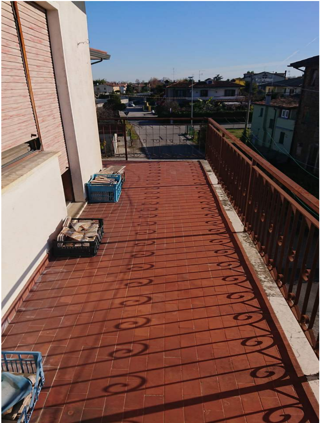
Foto n° 21 - 23/11/2021 - Comune di S.Stino di Livenza, foglio 14, part.163, sub.22 – Poggiolo.
