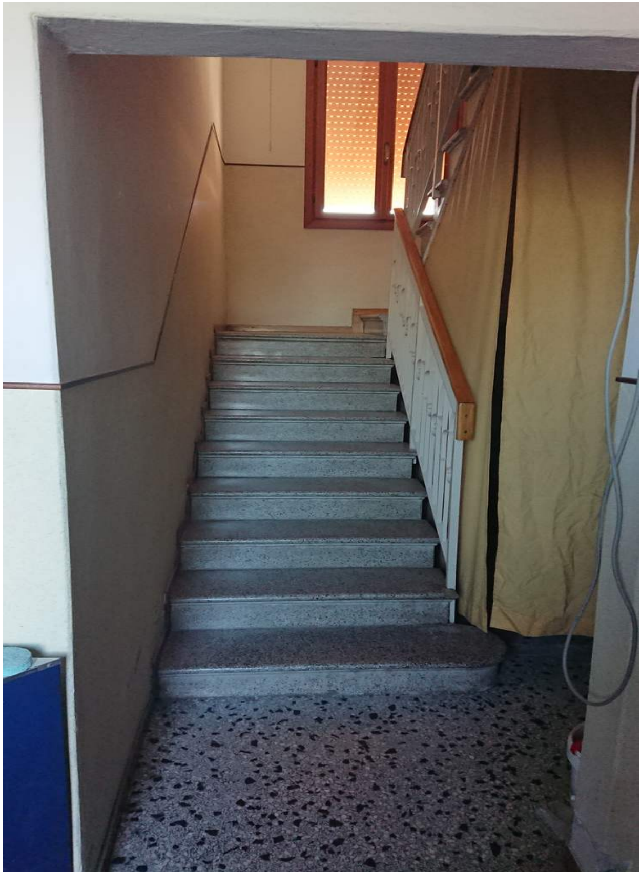
Foto n° 9 - 23/11/2021 - Comune di S.Stino di Livenza, foglio 14, part.163 – Vano scale che conduce ai piani superiori.
