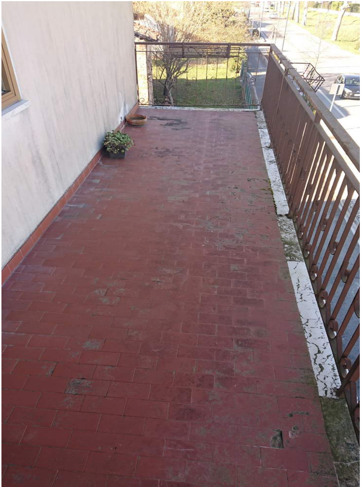
Foto n° 16 - 23/11/2021 - Comune di S.Stino di Livenza, foglio 14, part.163, sub.22 – Poggiolo.
