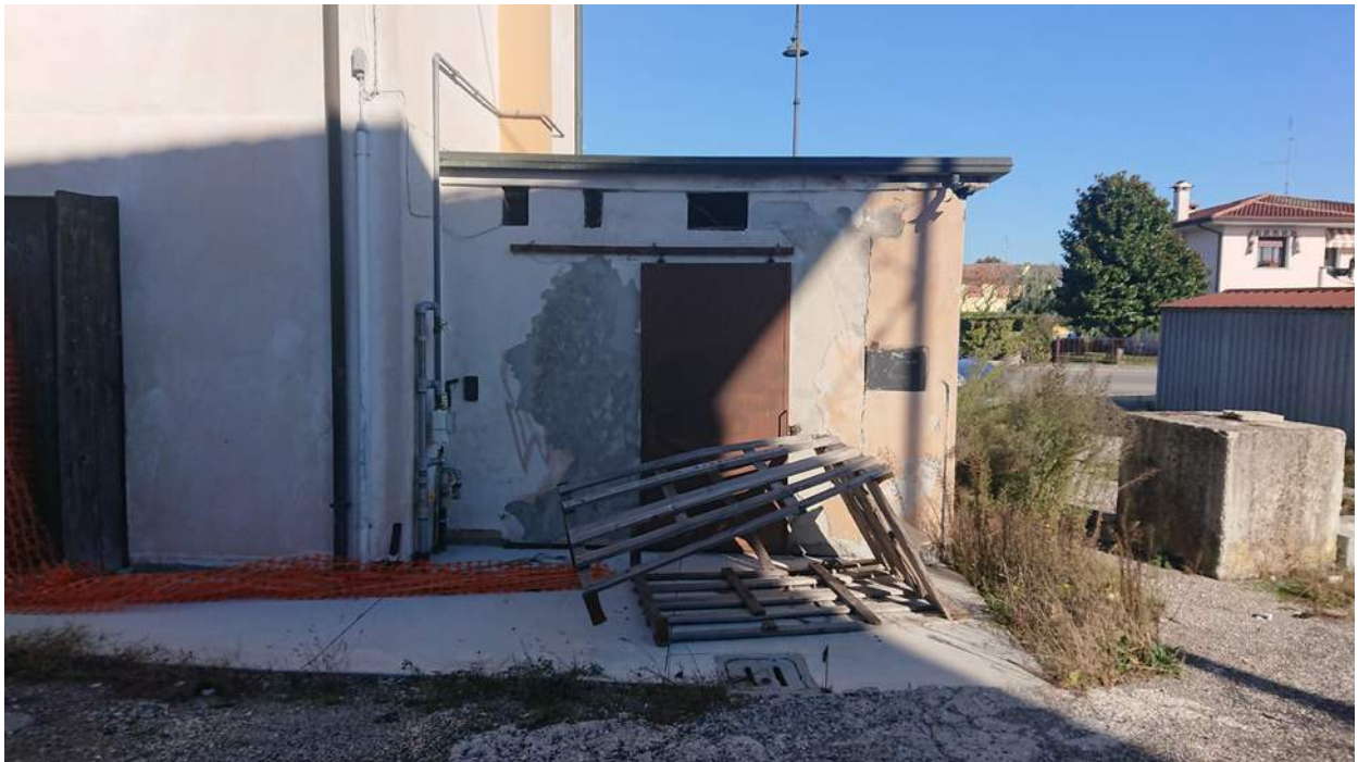
Foto n° 8 - 23/11/2021 - Comune di S.Stino di Livenza, foglio 14, part.163, sub.18 – Accesso al vano esterno catastalmente identificato come "wc".
