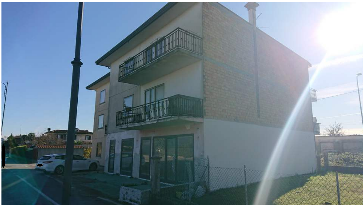
Foto n° 1 - 23/11/2021 - Comune di S.Stino di Livenza, foglio 14, part.163 – Visione esterna del fabbricato condominiale. Fotografia scattata da Viale Trieste.
