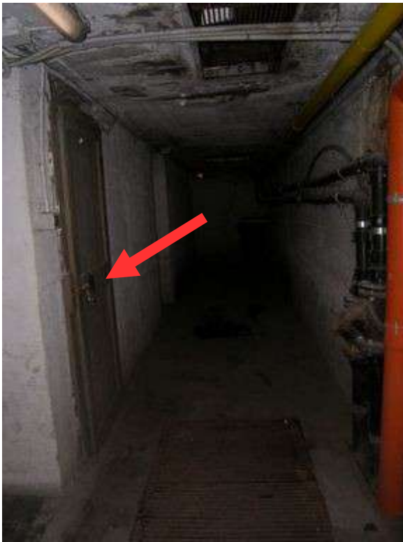
Vista corridoio cantina
