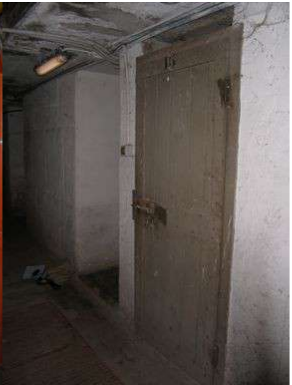
Vista porta cantina
