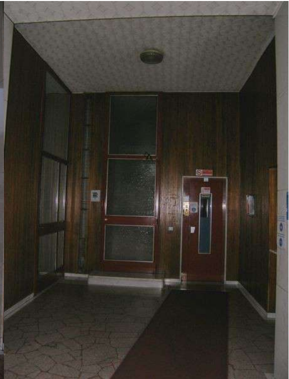
Vista prospetto interno
