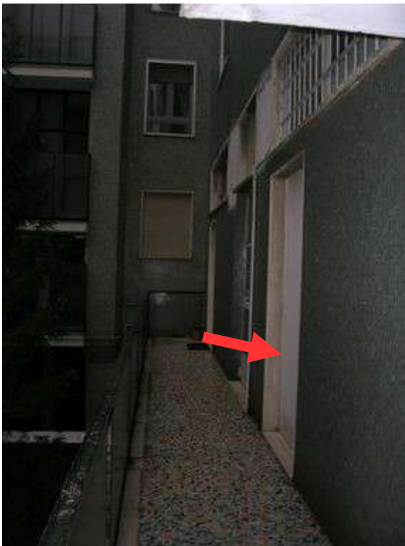
Vista ingresso da ballatoio interno
