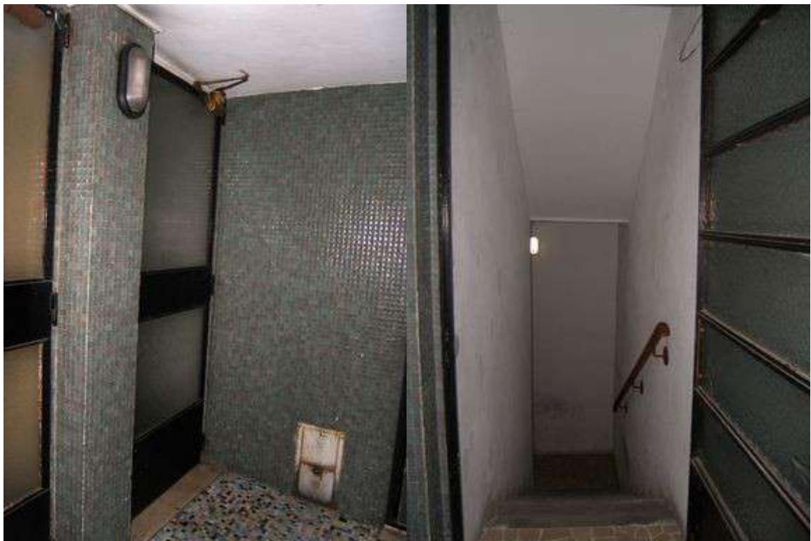
Vista porta accesso piano cantine su ballatoio
