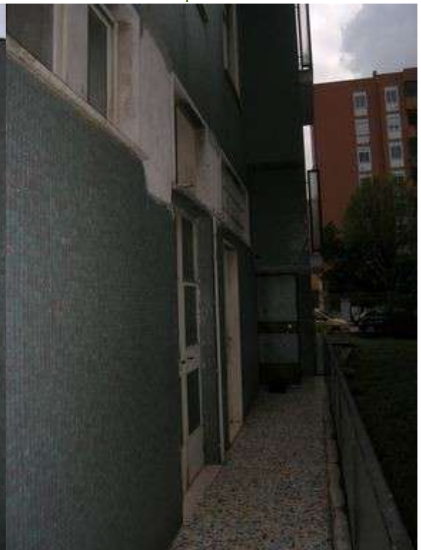
Vista ballatoio interno
