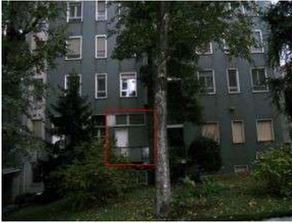
Vista prospetto interno
