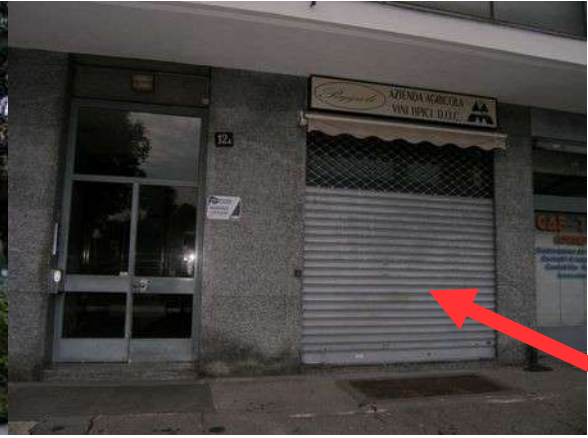
Vista prospetto interno
