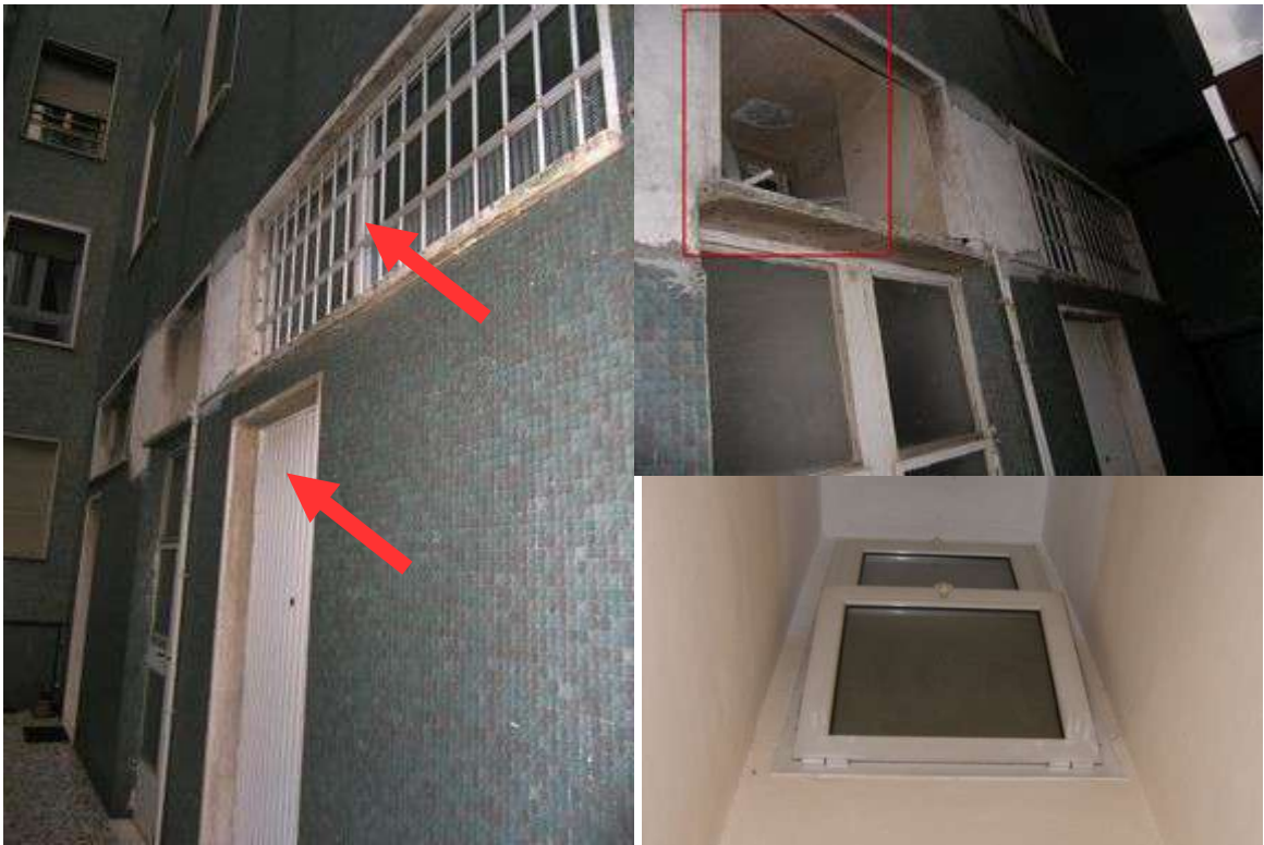
Vista ballatoio interno
