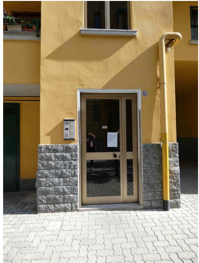
Foto 7. Portoncino d'accesso alla scala D dove è ubicato il solaio
