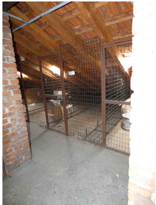
Foto 9. Corridoio d'accesso ai solai
