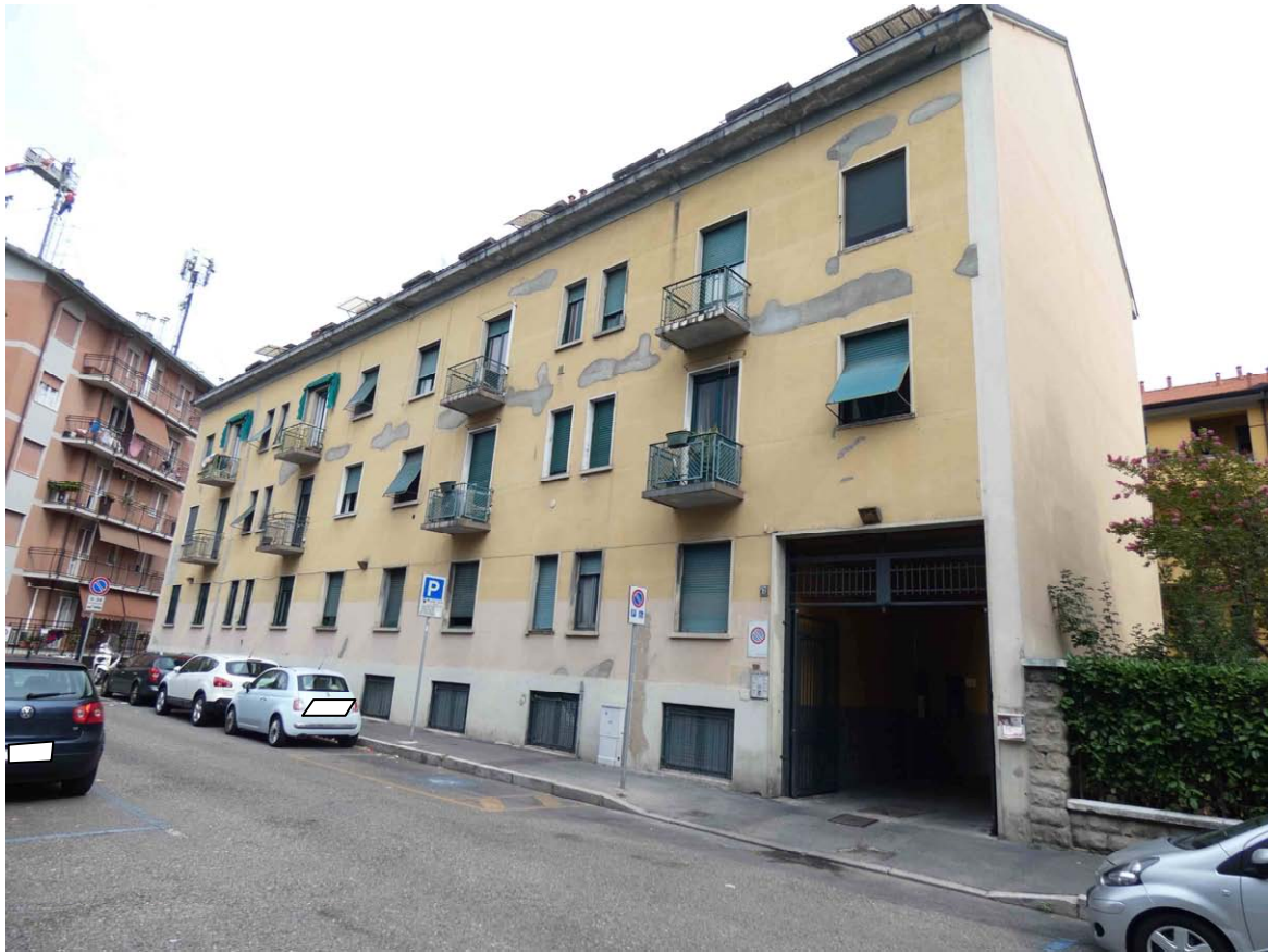
Foto 1. Prospetto su Via Privata Terracina
