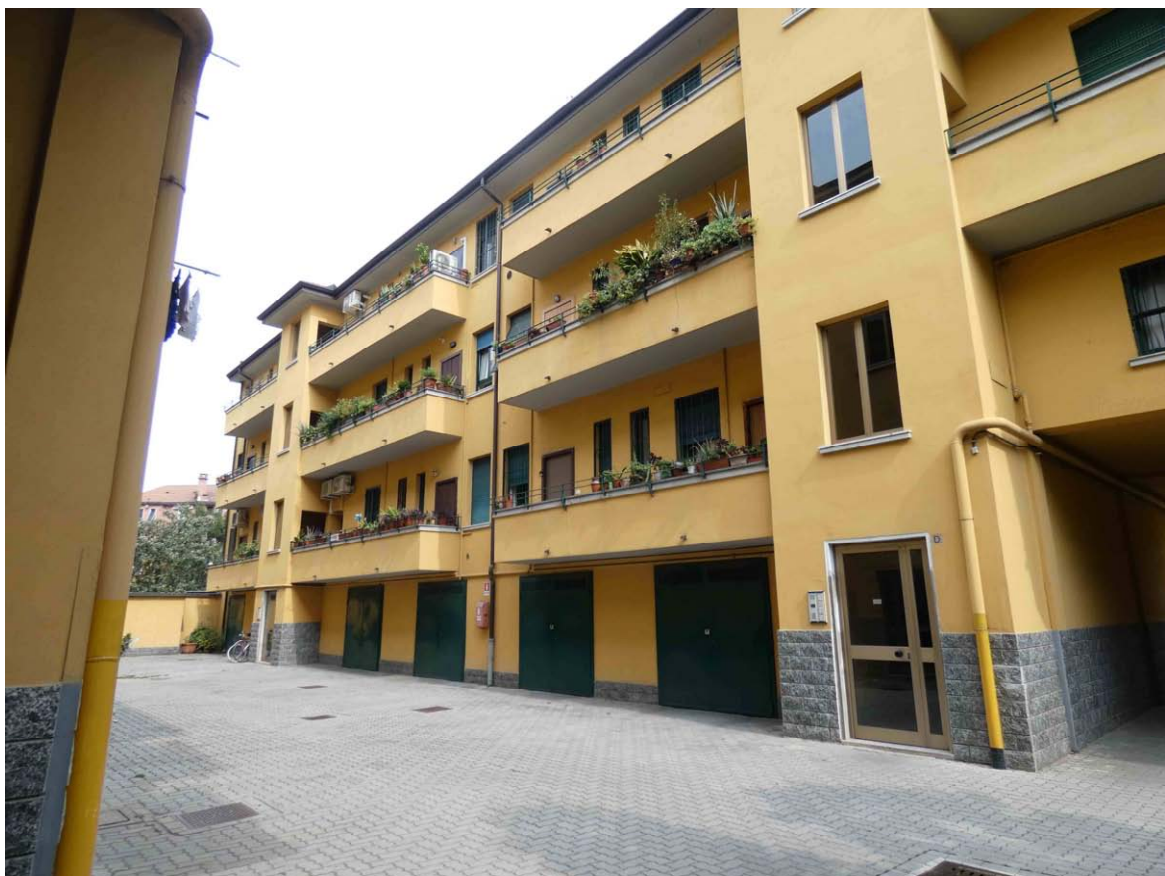
Foto 5. Edificio in affaccio sui cortili interni
