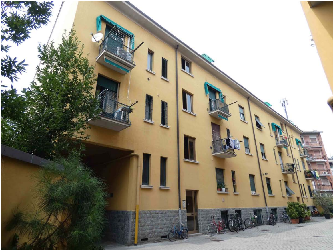
Foto 4. Edificio in affaccio su Via Privata Terracina
