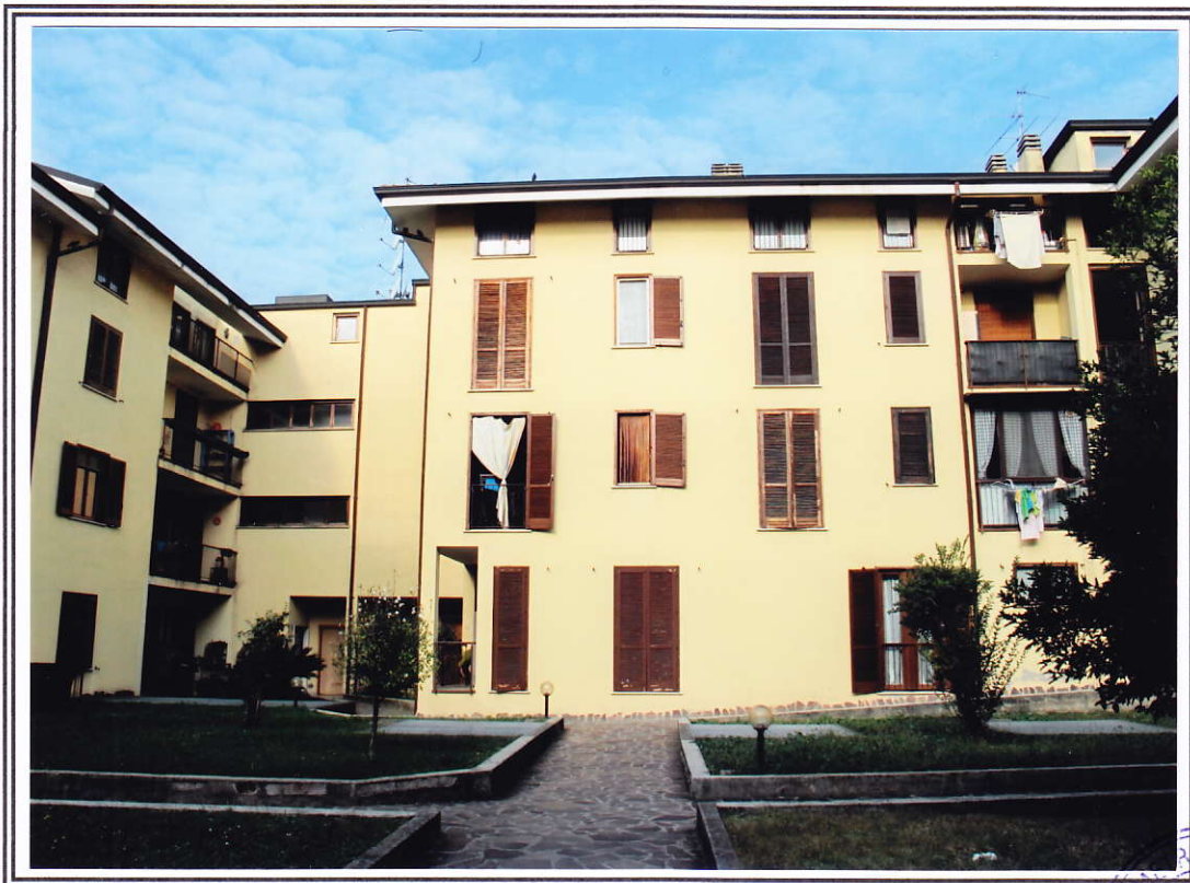
Esterno fabbricato - cortile comune
