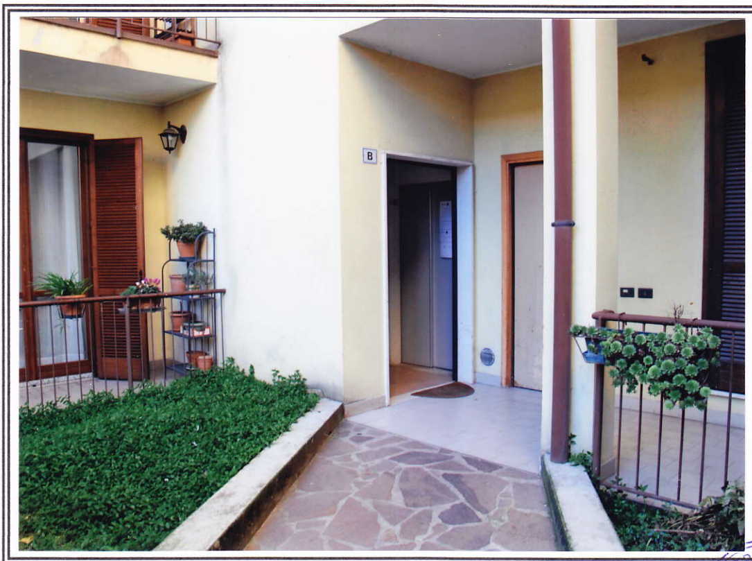
Esterno fabbricato – ingresso scala "B"
