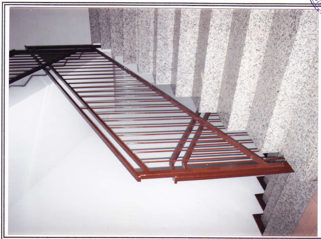
Interno fabbricato – vano scala "B" comune
