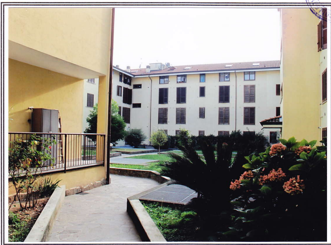
Esterno fabbricato - cortile comune zona ingresso scala "B"
