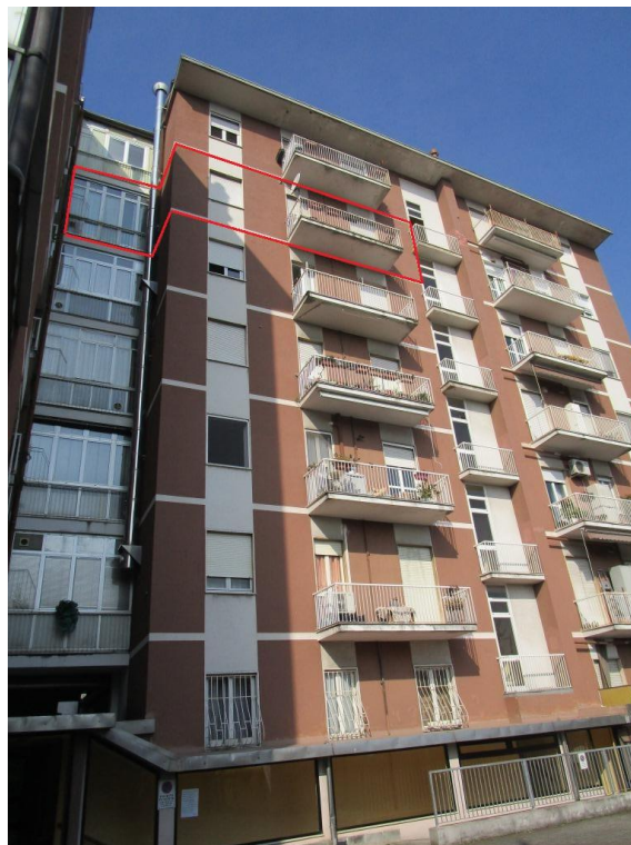
Foto 2 – Vista e inquadramento dal cortile interno, dell'unità immobiliare
