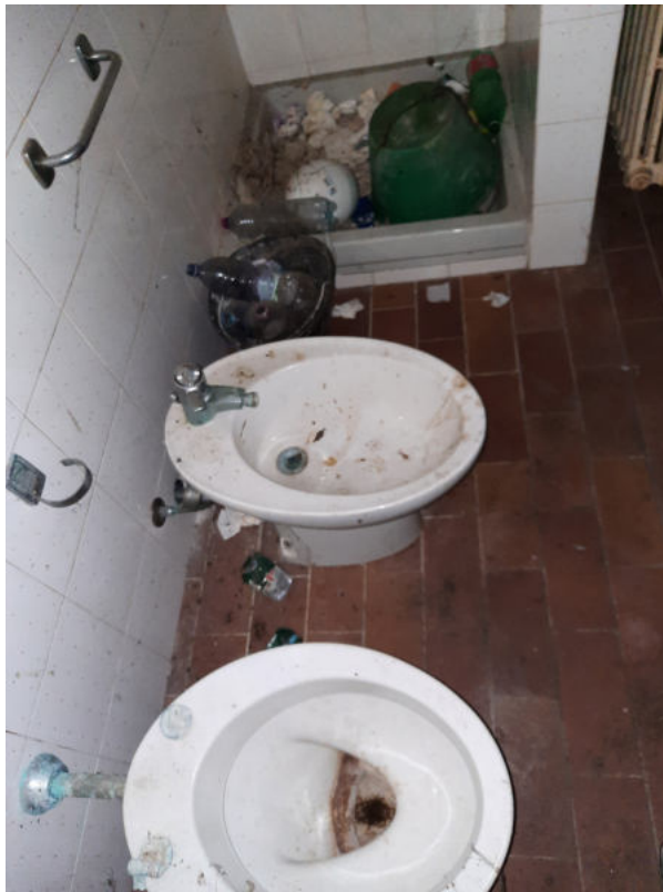
FOTO 10 – Interno Particella 81 sub. 701 locale bagno
