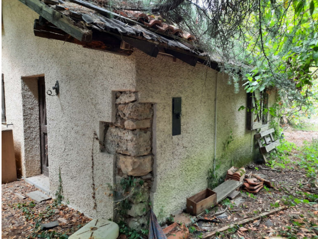
FOTO 3 – Fianco fabbricato Particella 81subalterno 701
