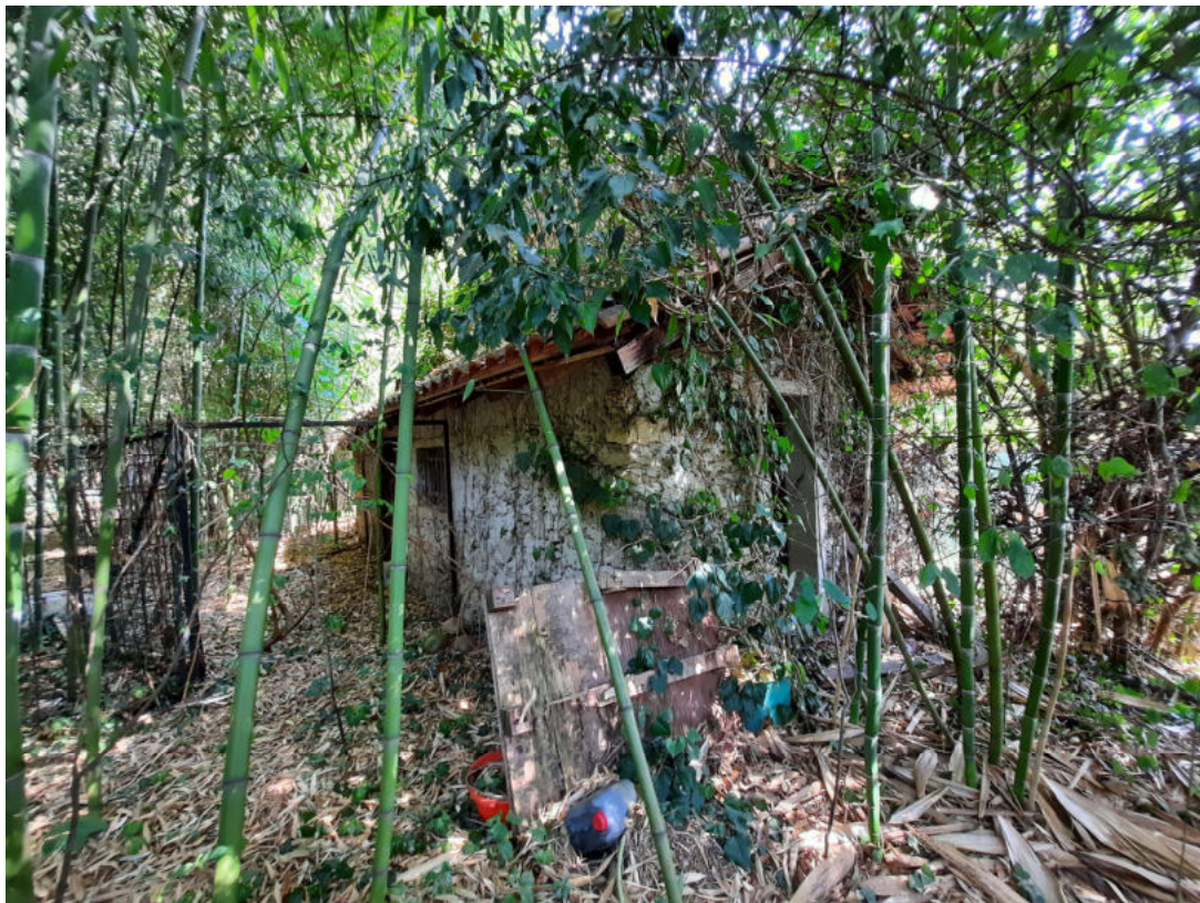
FOTO 14 – Costruzione Particella 79 sub. 701
