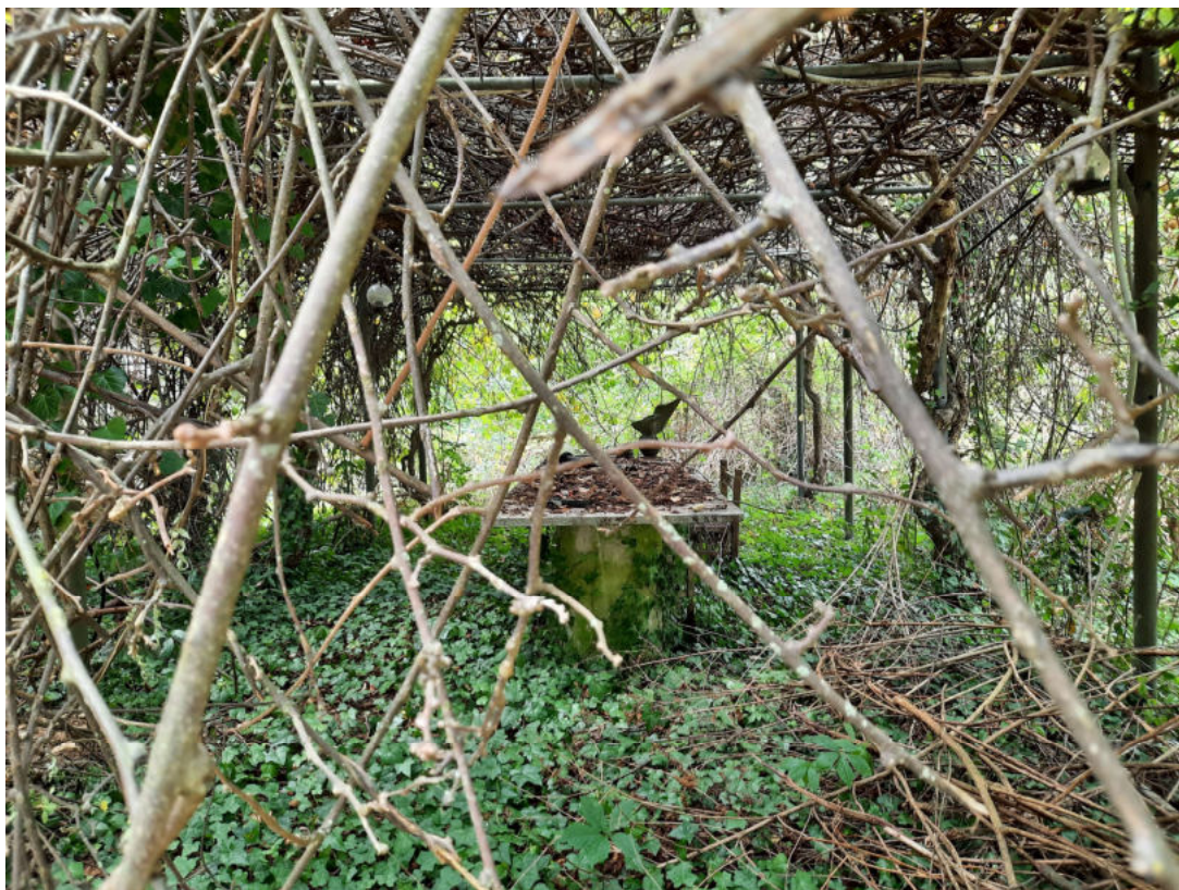
FOTO 16 – Pergola retrostante edificio particella 81 e stato della vegetazione
