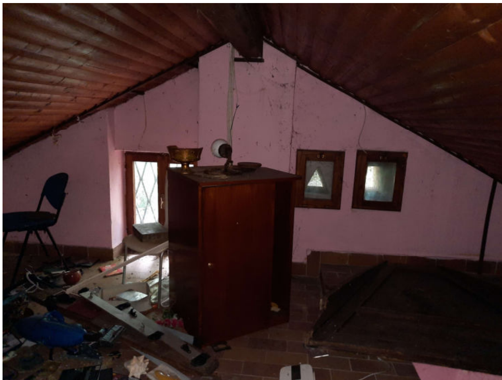
FOTO 6 – Interno Particella 81 sub. 701 soffitta
