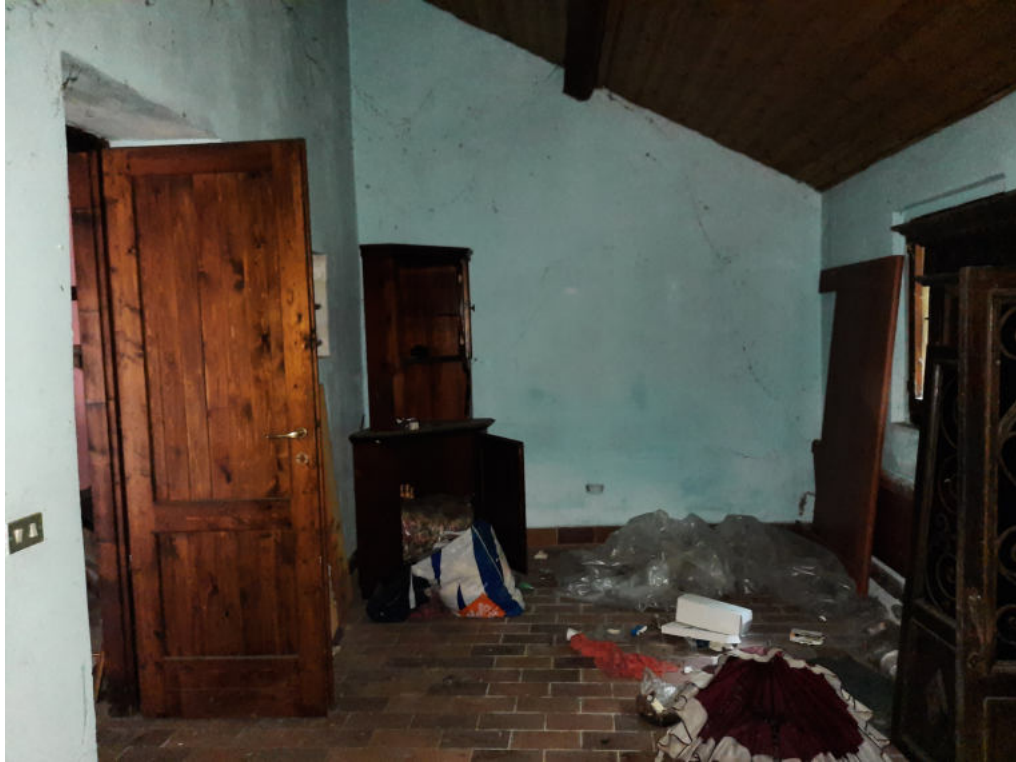
FOTO 7 – Interno Particella 81 sub. 701
