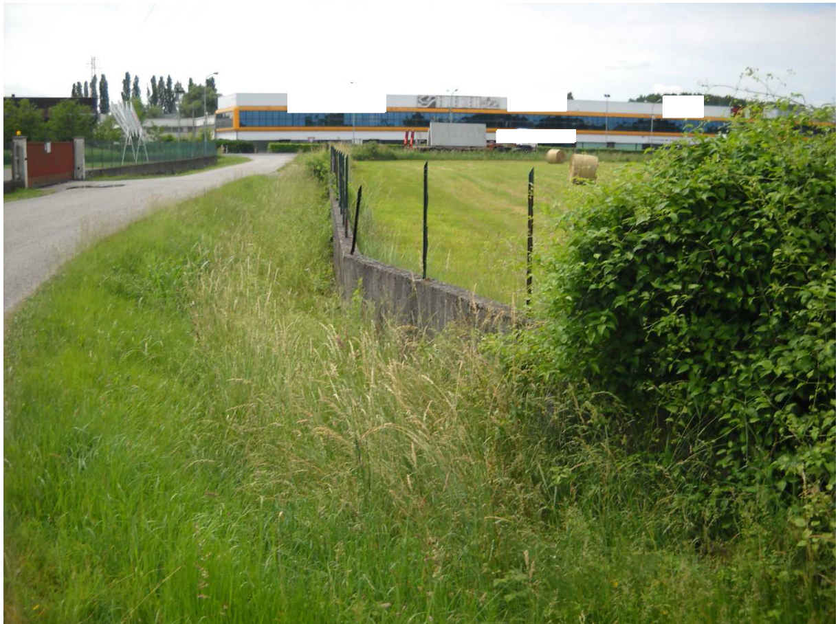
Foto 3 recinzione parziale esistente
