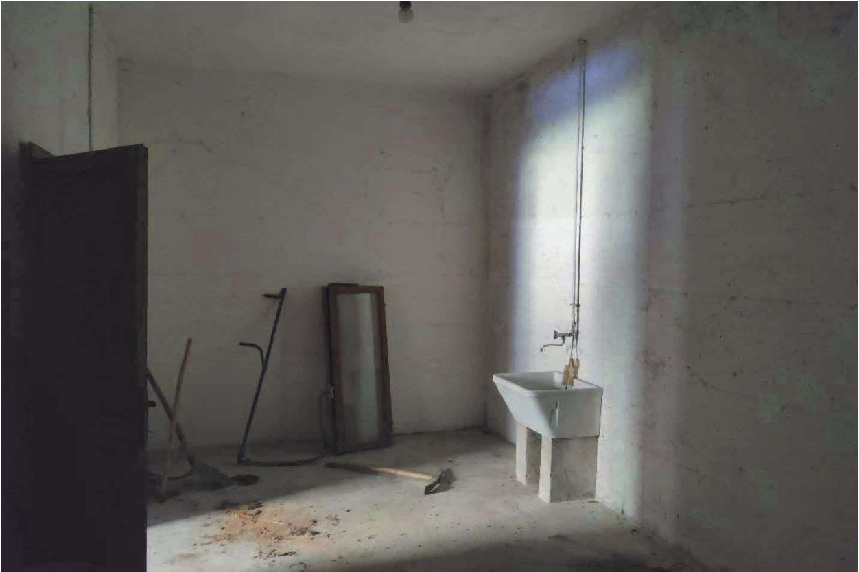
Foto n. 29 – Parte al grezzo – Cantina al piano terra.
