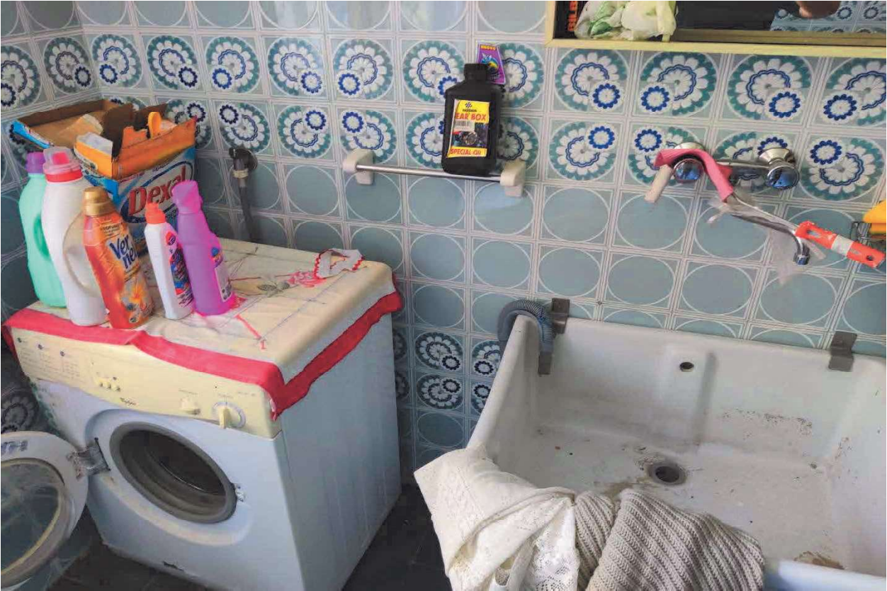
Foto n. 25 – Servizio igienico al piano terra – vano lavanderia.
