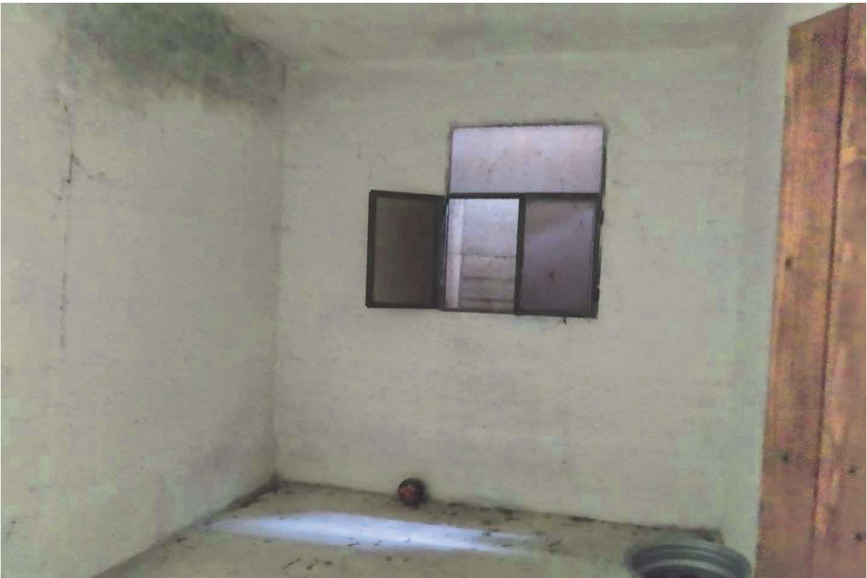
Foto n. 30 – Parte al grezzo – Cantina al piano terra.
