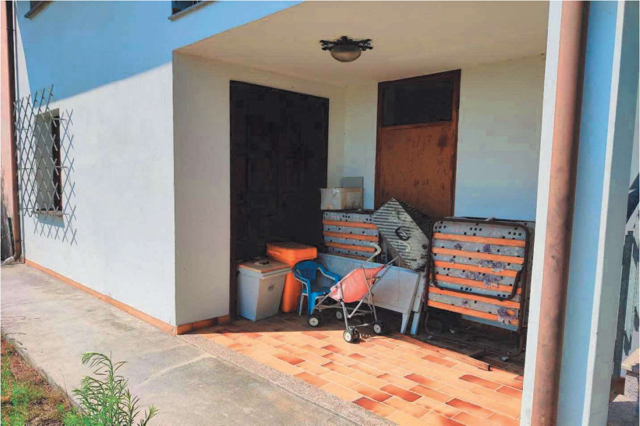
Foto n. 33 – Ingresso al piano terra. In evidenza accesso al locale caldaia.
