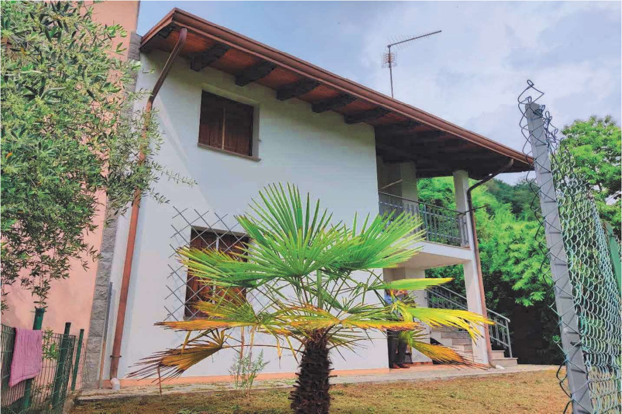
Foto n. 3 – Immobile esecutato visto dalla corte interna (facciata Sud).
