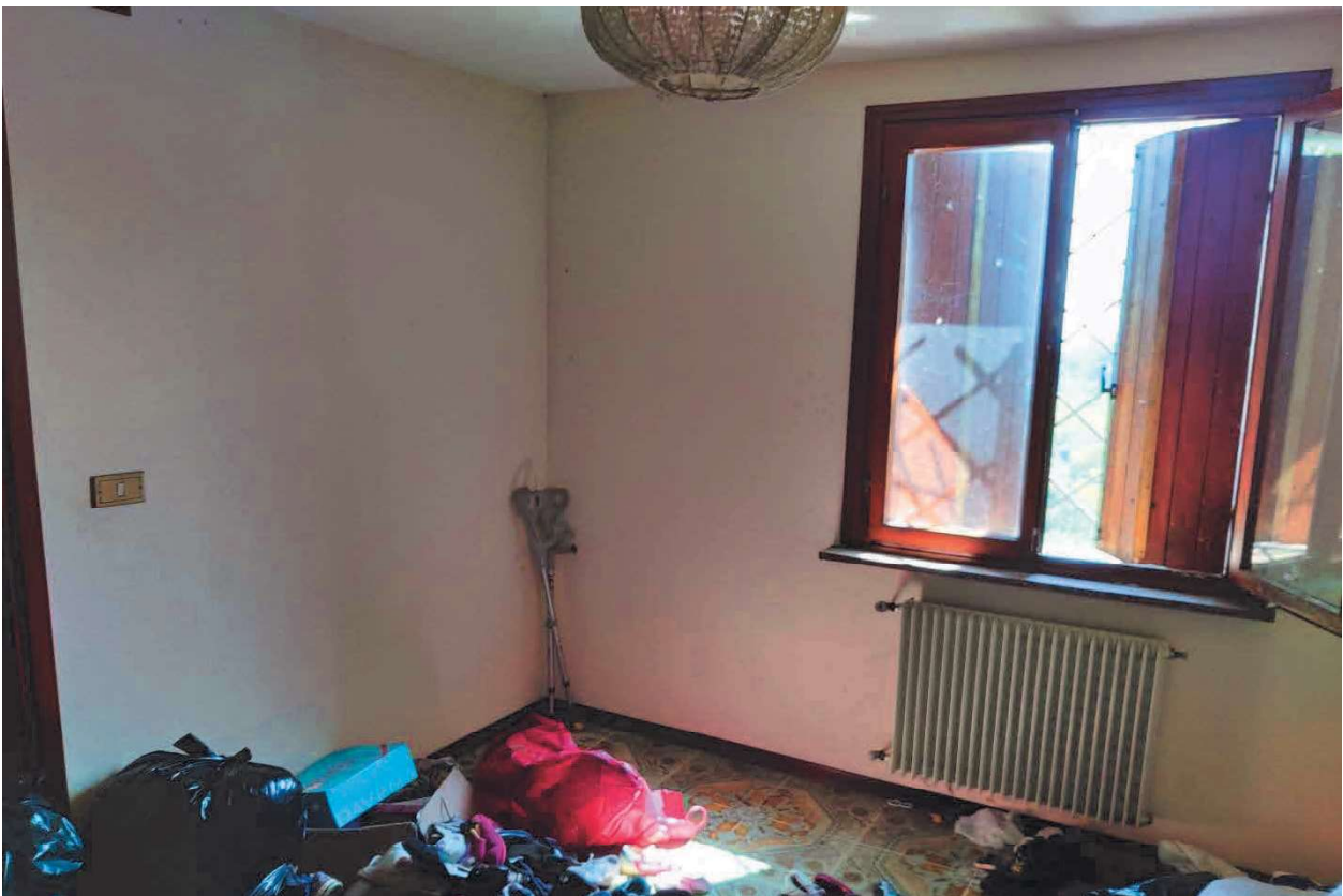
Foto n. 28 – Magazzino al piano terra, adattato a cameretta.
