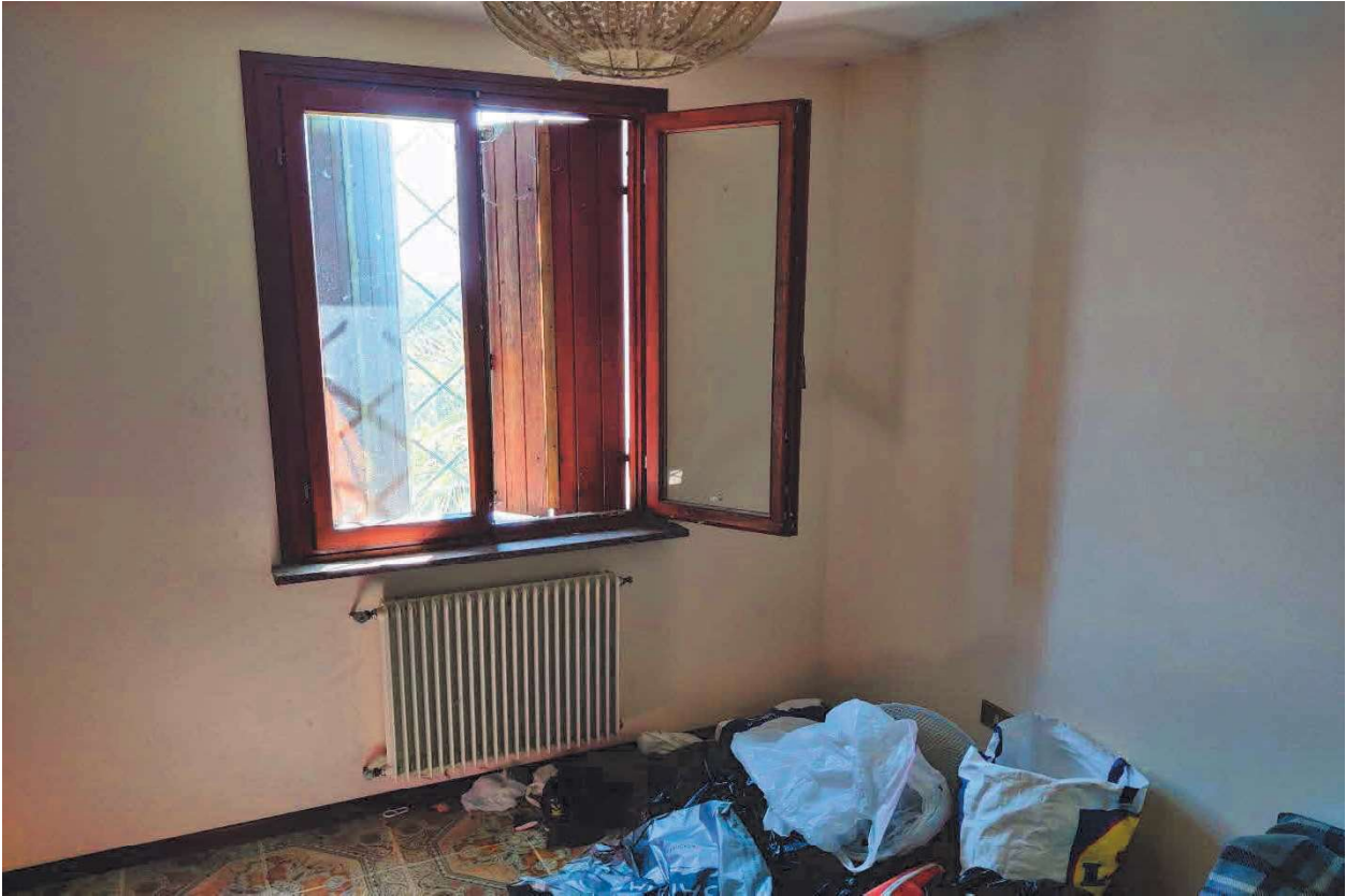
Foto n. 27 – Magazzino al piano terra, adattato a cameretta.
