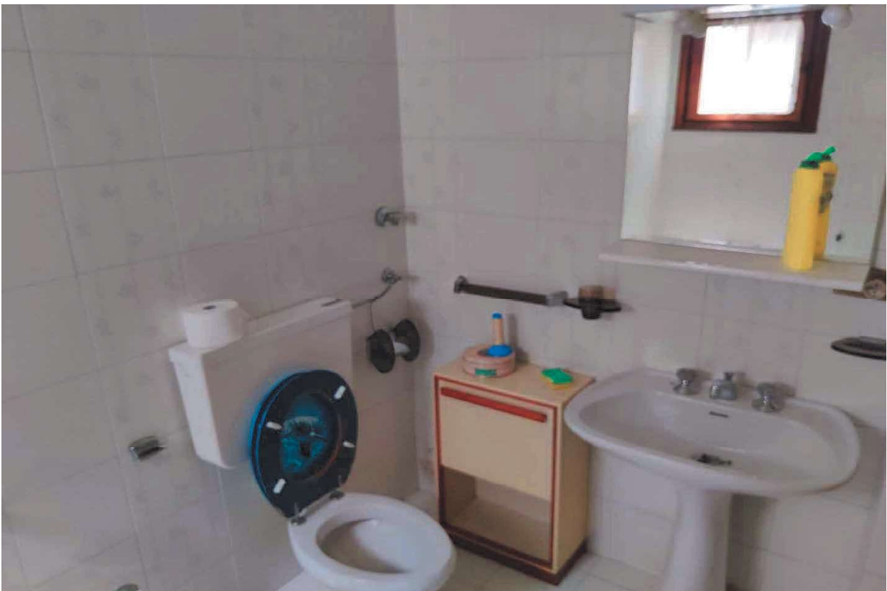
Foto n. 14 – Servizio igienico al piano primo.
