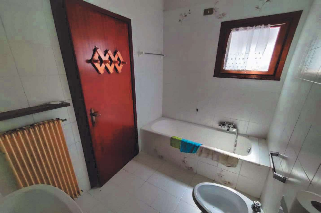
Foto n. 15 – Servizio igienico al piano primo.
