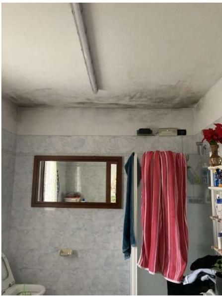
vista interna degrado del bagno/lavanderia con presenza di muffa
